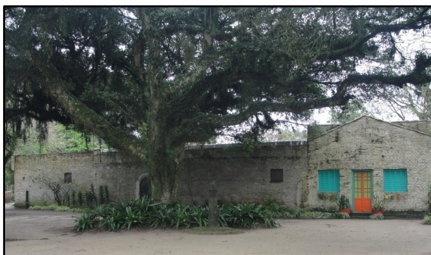
Figura 10 – Foto da fachada da senzala/galpão à esquerda e da casa do feitor à direita. Pelourinho a direita da figueira (Charqueada São João). Fonte: Banco de Dados, LEICMA, 2016.
