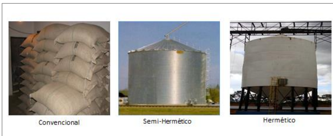
Figura 8 – Exemplos de armazenamento convencional, semi-hermético e hermético
