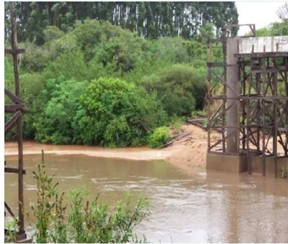
**Figura 5** – Obra de engenharia na BR-116, deslizamento de área não concluída, erosão, sedimentação, falta de proteção ciliar, falta de preservação de Área de Preservação Ambiental, presença de flora exótica (eucalipto).
