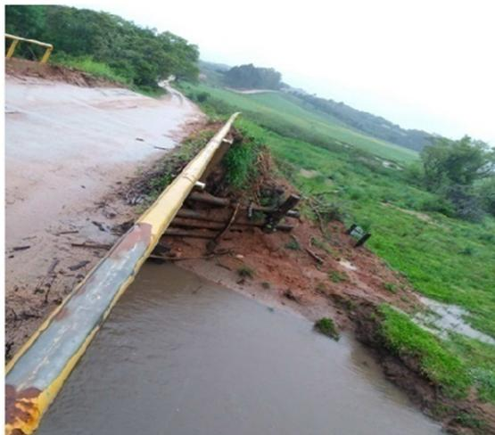
**Figura 1** – Ponte próxima ao arroio Candombe com estrutura frágil, perda do talude da ponte, local assoreado, elevação de lâmina de água devido a chuva, inundação de área sem características de banhado.
