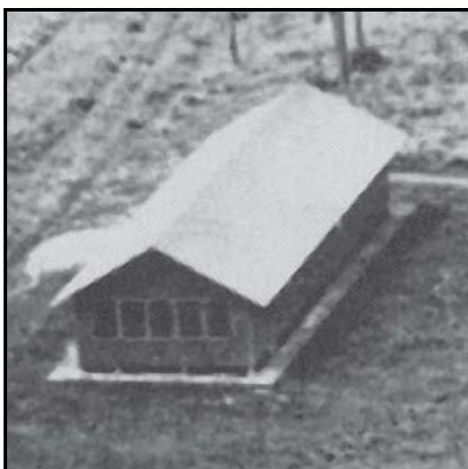
Figura 10: Brizoleta localizada na zona rural.
