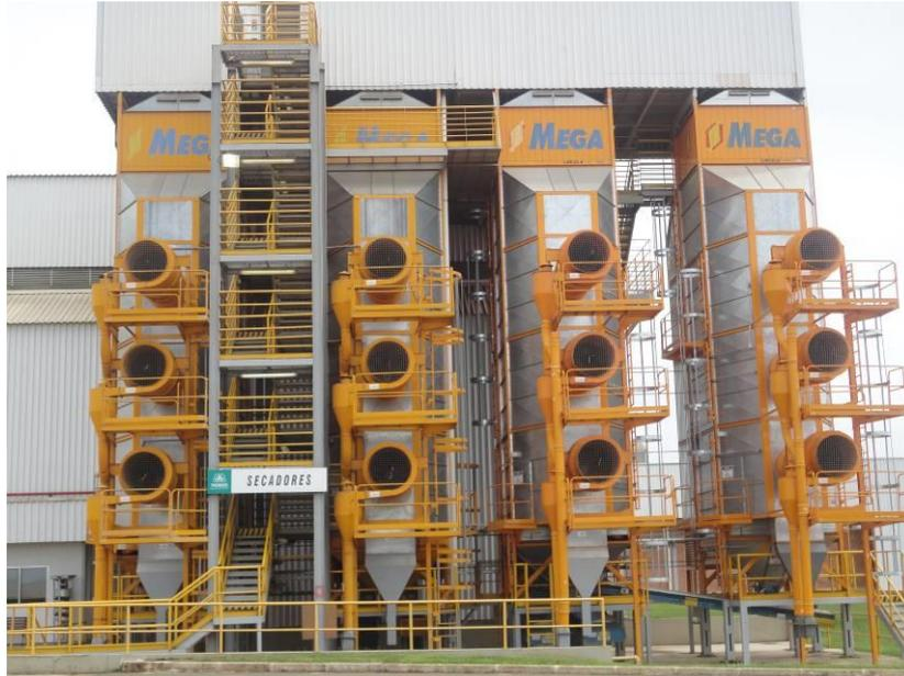
**Figura 1** – Secador MEGA, modelo TC 80 com capacidade para 40 toneladas.
