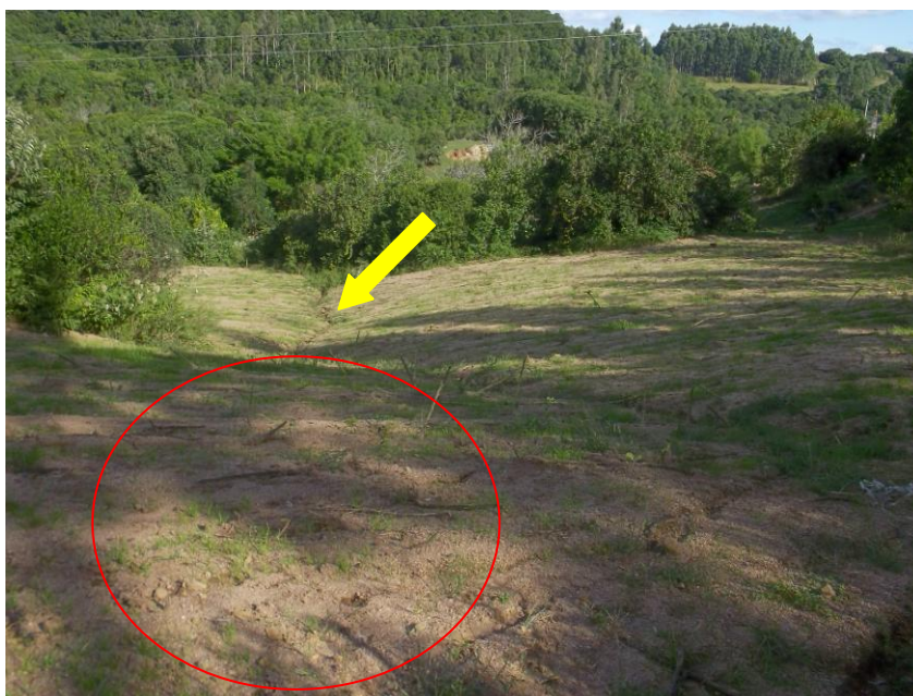
Figura 41: Processos erosivos laminar e linear no morro do Granito Arroio Moinho.
