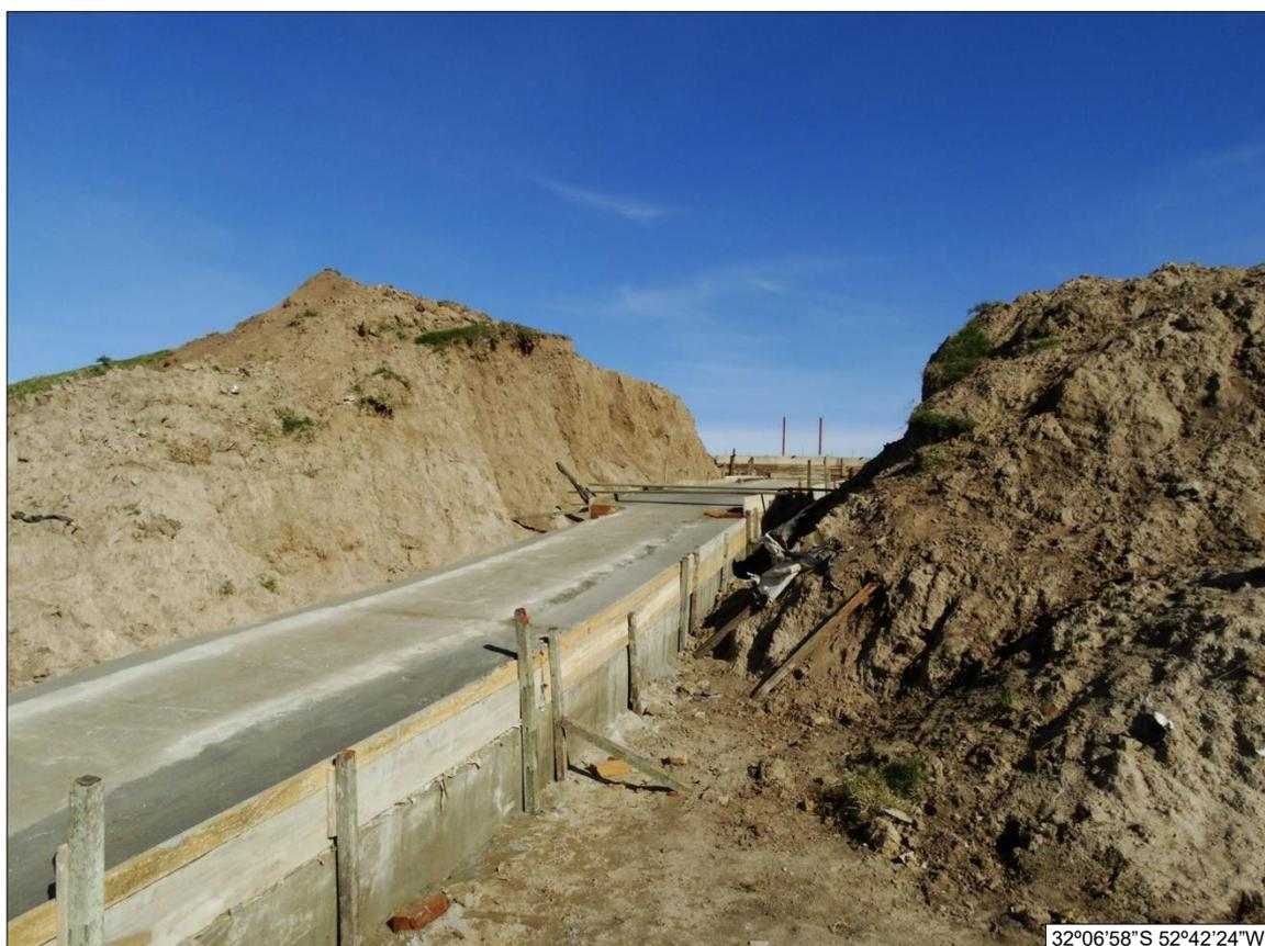
**Figura 21:** Obra de construção de levante hidráulico para bombeamento de água para os canais artificiais ativos em superfícies altimétricas superiores. **Fonte:** Arquivo pessoal
