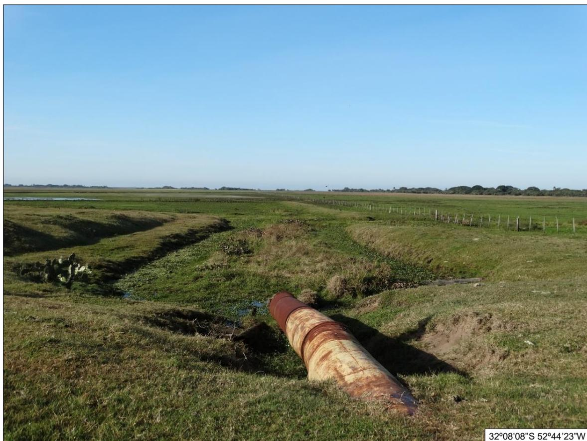
**Figura 22:** Antiga estação de captação de água para lavoura de arroz irrigado. O abandono do canal artificial é anunciado pelo assoreamento do leito artificial, pelo rompimento dos aterros marginais que garantiam sua existência e funcionalidade e pela depreciação do sistema de bombeamento de água existente. **Fonte:** Arquivo pessoal.
