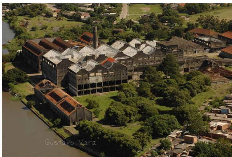
Figura 11 - Vista aérea da área do Anglo. Fonte: acervo NAUrb 4 , fotografia: Gustavo Vara.
