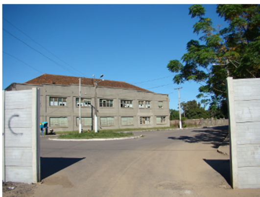
Figura 13 - Muro entre o campus e a Balsa. Fonte: acervo NAUrb, fotografias: Fernanda Tomiello, 2010.
