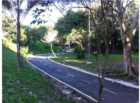
Figura 3.10. Vista parcial do setor 4. Fonte: A autora (2015).
