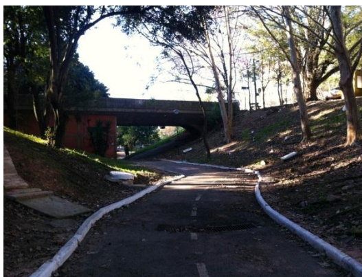
Figura 4.8. A visibilidade no Setor 3 é prejudicada pelo viaduto e taludes.
