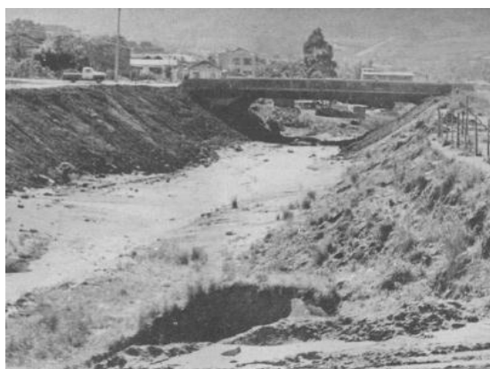
Figura 3.12. Antes da construção do parque o arroio Itaimbé com pinguelas de madeira.
