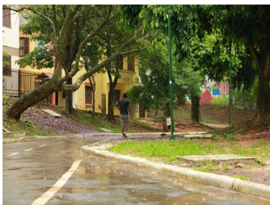
Figura 4.30. Os trechos asfaltos alagam durante as chuvas.
