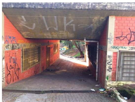
Figura 4.25. Pichação nos espaços situados abaixo dos viadutos.
