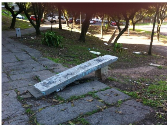
Figura 4.26. Situação dos bancos com assento de concreto.
