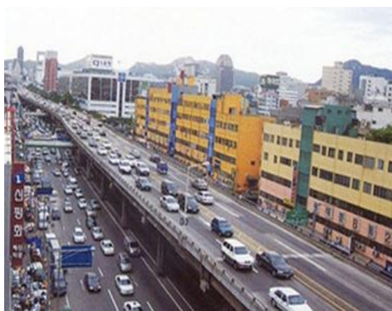
Figura 2.5. A Cheonggye Expressway, em Seul.
