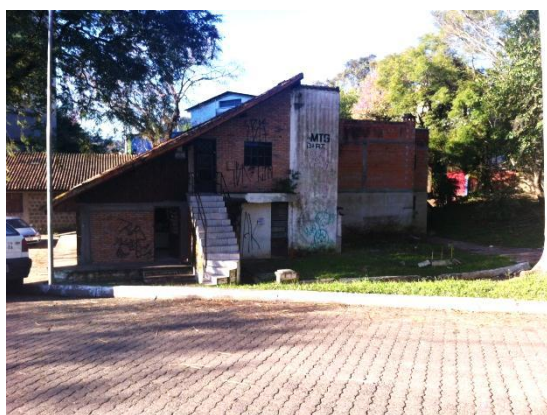
Figura 4.24. Pichação no quiosque no Setor 1.
