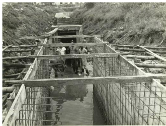
Figura 3.13. Canalização do arroio Itaimbé.
