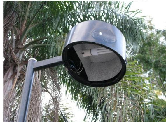
Figura 3.17 – Luminária sem vidro de proteção e amassada
