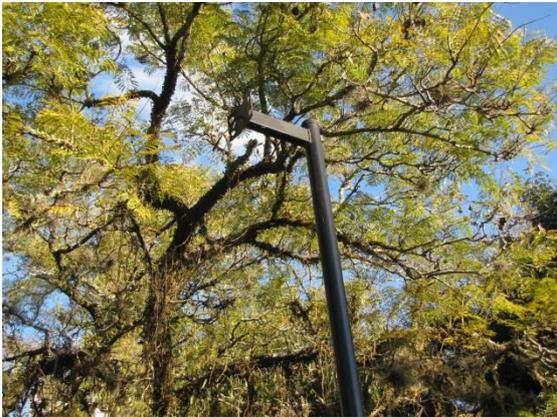
Figura 3.16- Luminária quebrada, sem refletor e sem lâmpada
