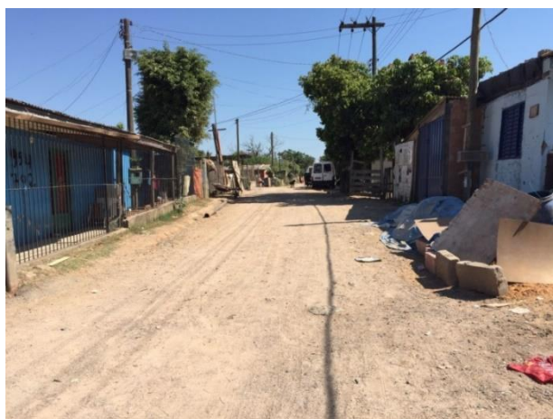
Figura 2.23: Situação atual da Vila Dique, Porto Alegre.
