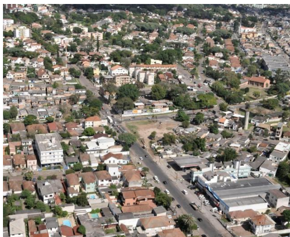
Figura 3.4: Área para a construção da rótula da Avenida Mazon com Avenida Tronco no trecho 2. Fonte: SECOPA, 2014a.
