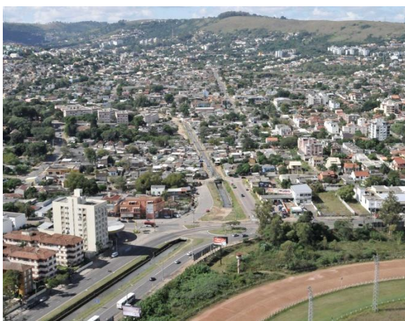
Figura 3.6: Área de duplicação na Avenida Icarai com Avenida Tronco no trecho 4. Fonte: SECOPA, 2014a.
