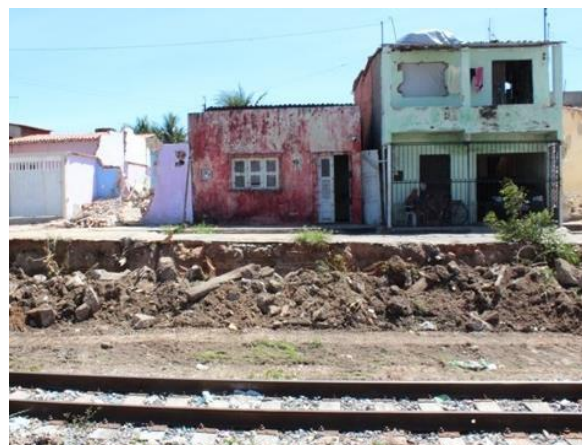
Figura 2.27: Local da construção do VLT em Fortaleza.
