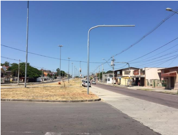
Figura 4.22: Trecho 3 da Avenida Tronco, Porto Alegre, em 24/01/2016. Fonte: Silva, 2016.
