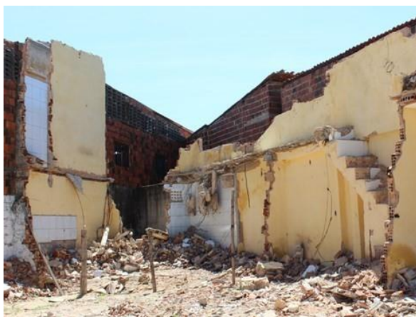
Figura 2.26: Demolição de casas em Fortaleza em 2013.
