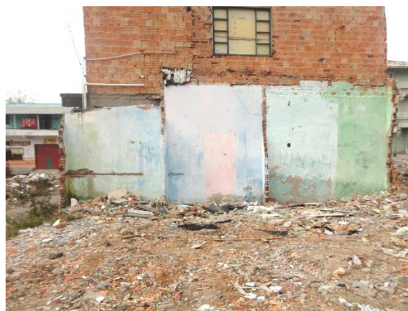
Figura 4.11: Demolição de residência geminada na Avenida Tronco. Fonte: Silva, 2014.
