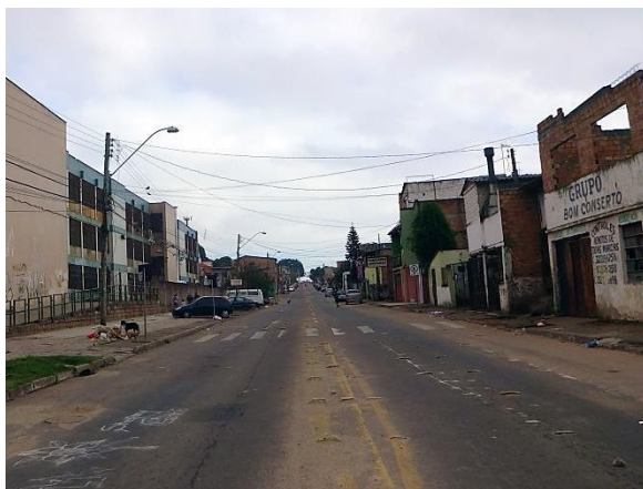
Figura 4.20: Duplicação da Avenida Tronco no trecho 2, em 18/05/2014.
