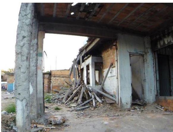
Figura 4.10: Ferros suspensos na demolição da residência na Avenida Tronco. Fonte: Silva, 2014.
