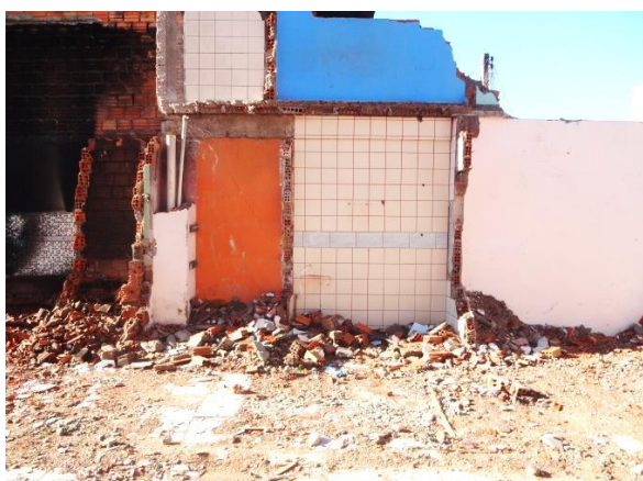
Figura 2.24: Demolição das casas na Avenida Tronco, Porto Alegre.
