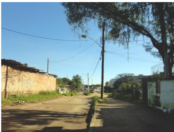
Figura 4.16: Trecho 4 na Avenida Tronco antes das obras, em 19/06/2014. Fonte: Silva, 2016.
