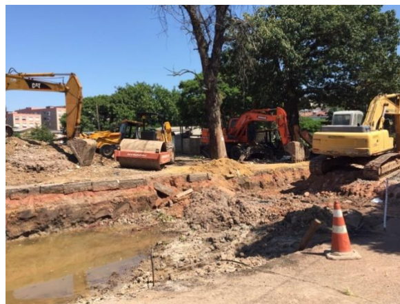
Figura 4.17: Trecho 4 na Avenida Tronco em obras, em 24/01/2016. Fonte: Silva, 2016.
