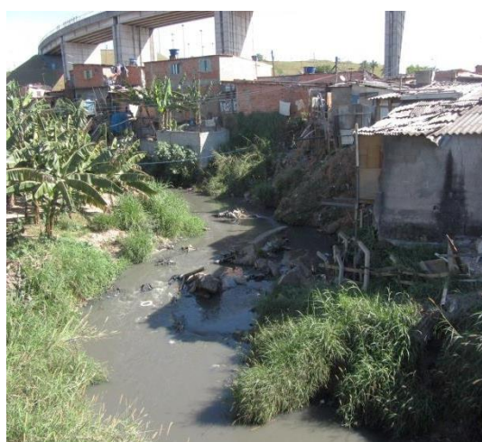
Figura 2.29: Habitações a serem removidas junto ao córrego em Itaquera, São Paulo.
