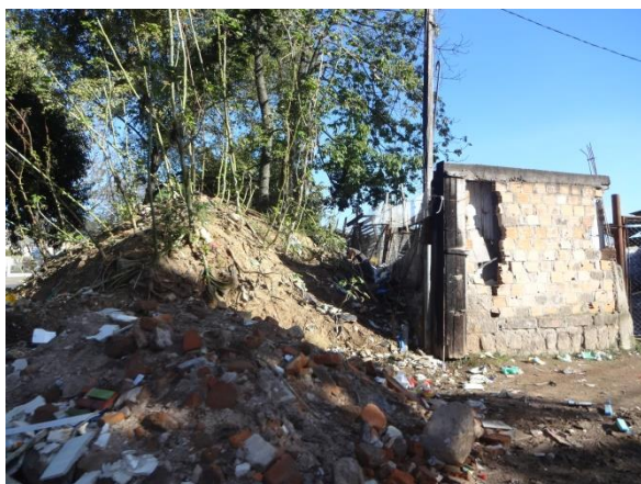
Figura 4.8: Escombros das casas demolidas na Avenida Tronco em 19/06/2014. Fonte: Silva, 2014.
