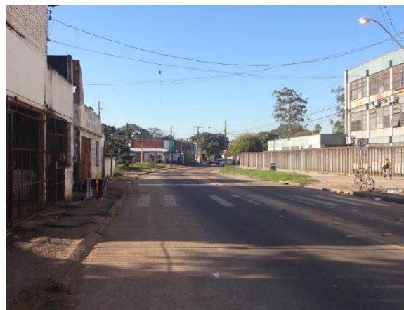
Figura 4.21: Duplicação da Avenida Tronco no trecho 2, em 12/06/2015.
