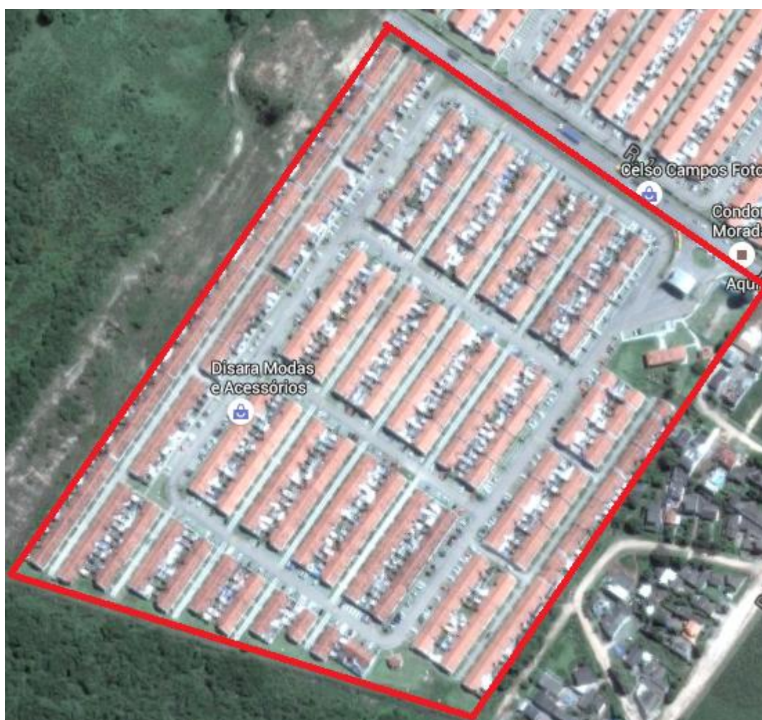
Figura 72 – Vista aérea do Residencial Moradas Pelotas.
