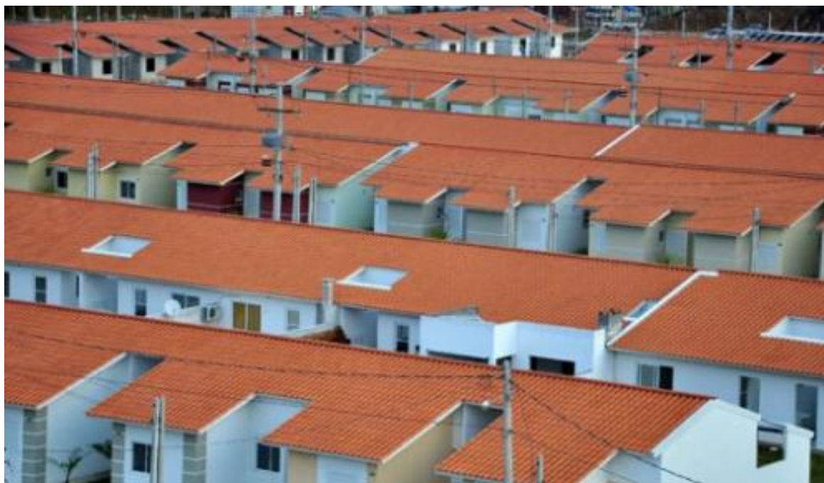
Figura 65 – Vista geral do Residencial Terra Nova.
