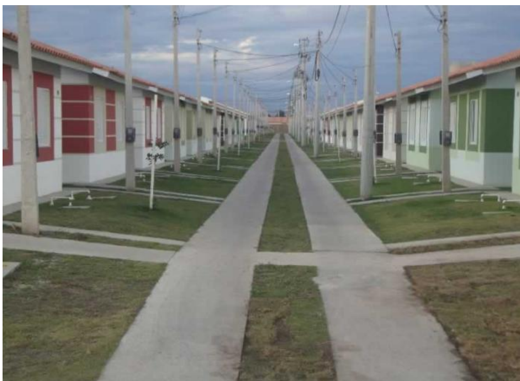
Figura 71 – Vista interna do Residencial Moradas Pelotas.
