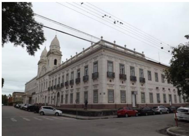
Figura 4.1 - Vista do Hospital Santa Casa de Pelotas, RS. Fonte - Lopes, 2015.
