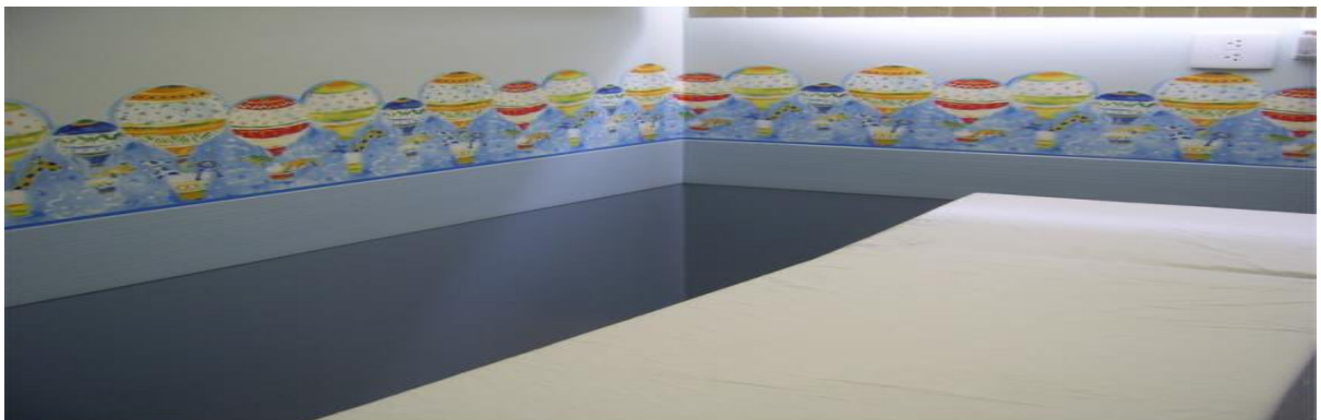
Figura 3.14 - Faixa com cor, delimita, ambienta e protege (bate macas).
