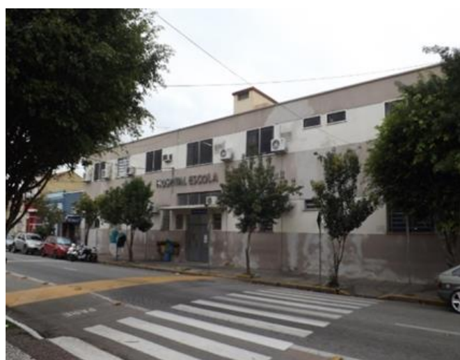
Figura 4.2 - Fachada principal do Hospital Escola, Pelotas, RS. Fonte - Lopes, 2015.
