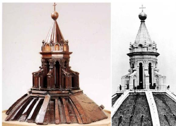
Fig. 16 Esq. Modelo em madeira do lanternim para a cúpula. Brunelleschi; Dir. Lanternim edificado. Fonte: BASSO (2005).
