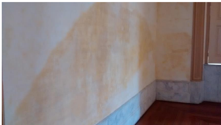
Figura 124 – Manchas de umidade nas paredes do ambiente de sala de exposições do Casarão 8, dezembro de 2015.
