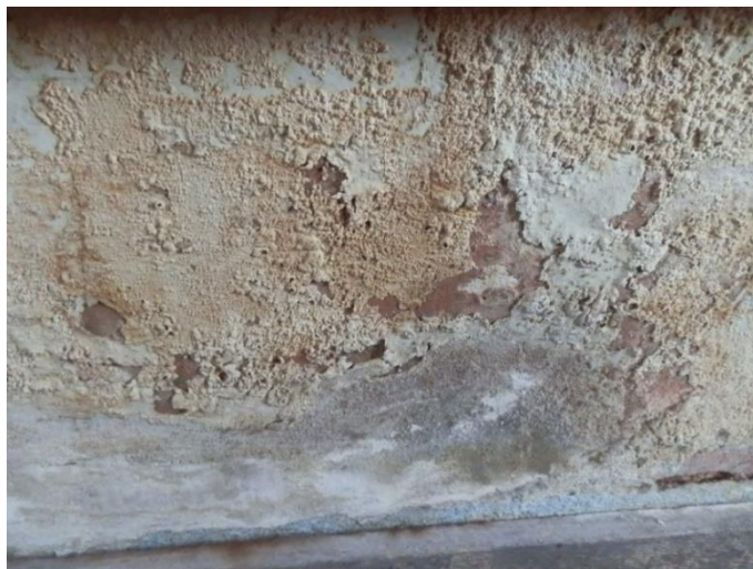
Figura 20 – Eflorescência com causa de umidade por capilaridade.
