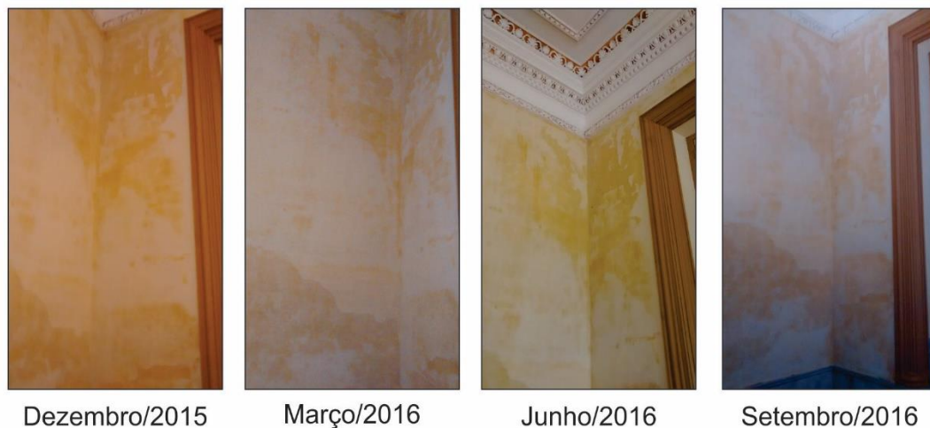
Figura 135 – Comportamento das manchas de umidade no ambiente de exposições do Casarão 8. Fonte: A autora.
