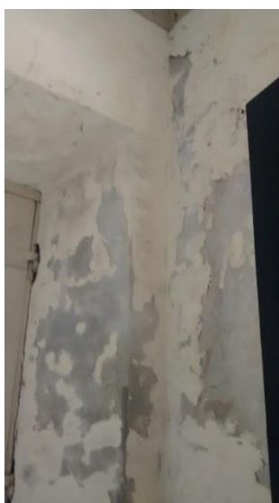
Figura 122 – Manifestação patológica de descolamento com causa na umidade por infiltração.
