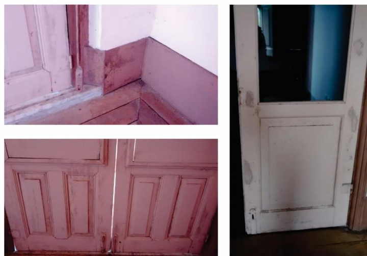
Figura 137 – Presença de fungos em elementos de madeira do ambiente administrativo do Casarão 6, setembro de 2016.
