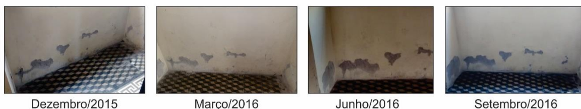
Figura 131 – Comportamento de manifestação patológica por umidade ascendente no ambiente de exposições do Casarão 2.
