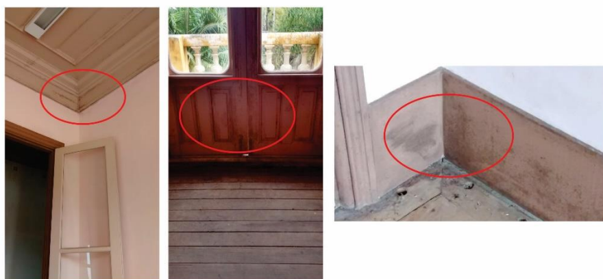
Figura 129 – Presença de fungos em elementos de madeira do ambiente administrativo do Casarão 6, junho de 2016.
