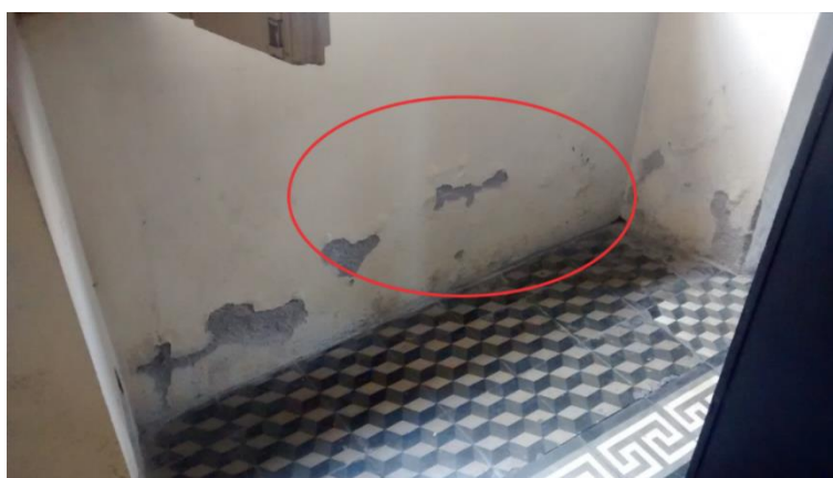
Figura 22 – Descolamento com empolamento, com causa de umidade por capilaridade.
