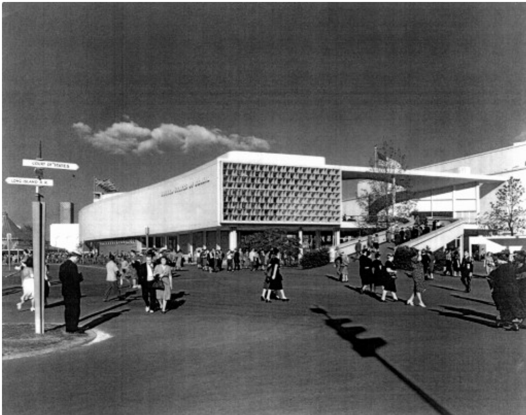
Figura 65: Foto do pavilhão construído desde a esquina Fonte: Comas, 2010
