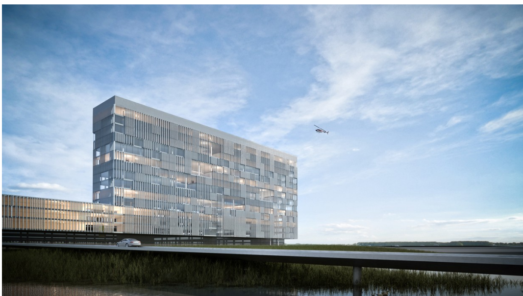
Figura 114: Vista do edifício e da via de acesso
