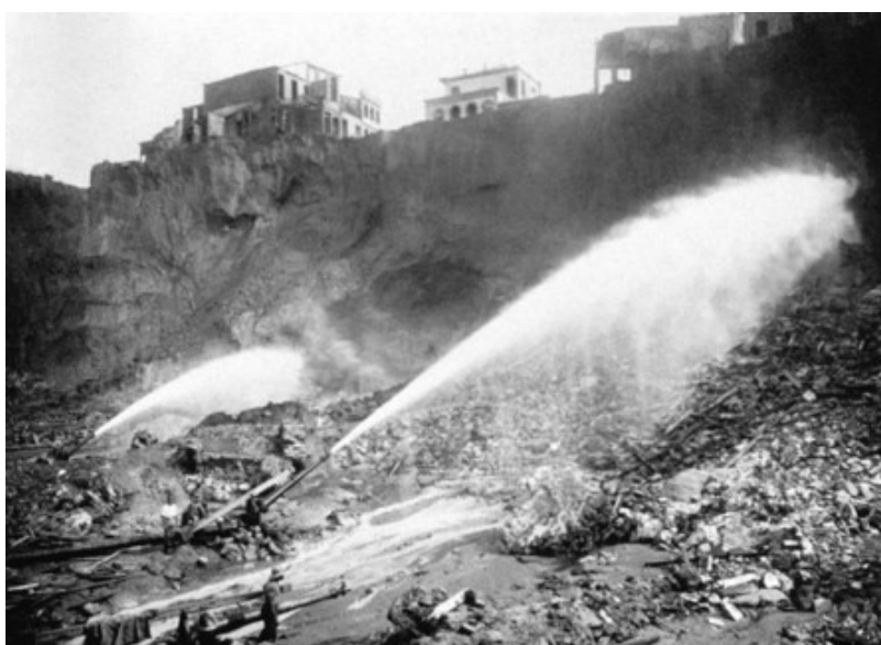
Figura 42: Desmanche Morro do Castelo
