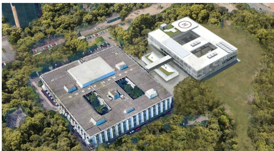
Figura 127: Vista aérea projeto Epime Engenharia
