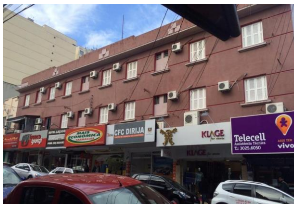
Figura 4.18: Fachada 85 (loja 81 a 87).
