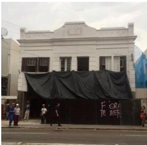
Figura 3.17 (a): Edificação desocupada na Rua do Acampamento no ano de 2016. Fonte: Autora, 2016.
