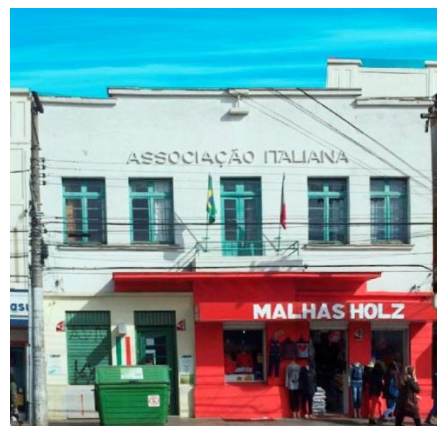
Figura 4.13: Fachada 22, edificação de interesse histórico e cultural.
