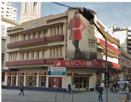
Figura 2.11: Prédio Magnabosco antes da intervenção. Fonte: Fiamenghi, 2013.
