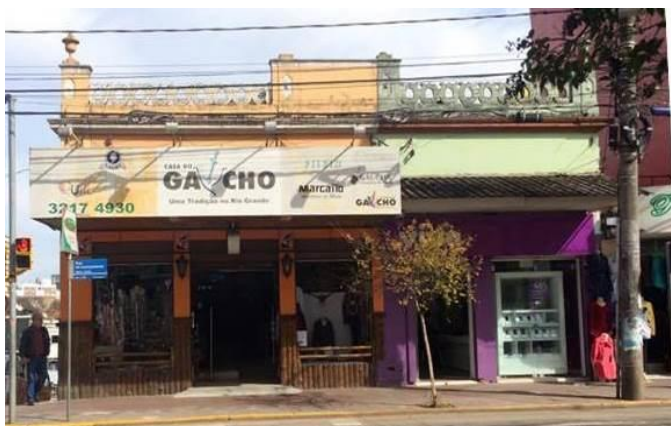
Figura 4.12: Fachada 18, edificação de interesse histórico e cultural.
