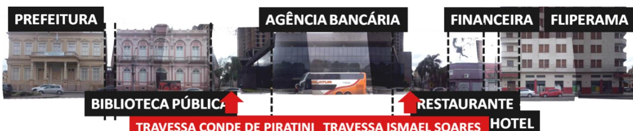
Figura 3.13 - Entorno da praça. Perfil da Rua XV de Novembro. Fonte: autora, 2018.
