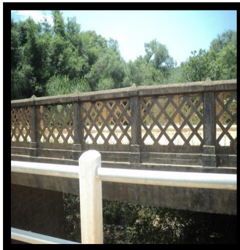
Figura 55: Ponte sobre o Arroio Quilombo Fonte: acervo da pesquisadora
