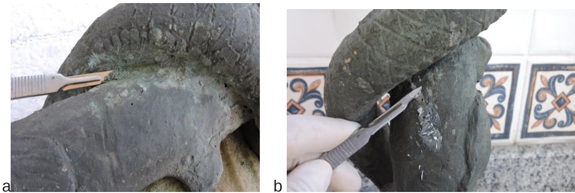
Figura 15: Limpeza mecânica para remoção de sujidades (a;b). Fonte: Gabriel Faro (a;b), 2017.
