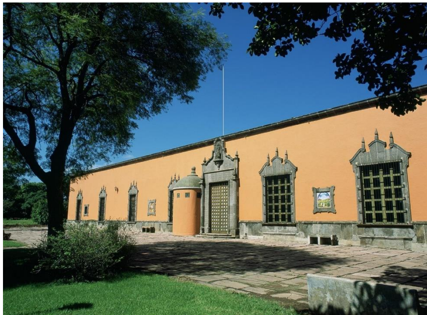
Figura 39: Fachada de la Ex Hacienda la Providencia en el Arenal, Jalisco. Se ubica en la parte central del poblado El Arenal, en la margen del río que cruza la localidad. el complejo consta de jardines de acceso, casa grande, patios y fabrica del tequila. La fábrica ya no está en operación, pero conserva toda su maquinaria y aparatos. Actualmente se usa para eventos sociales y culturales. Fuente: GOBIERNO MUNICIPAL EL ARENAL, 2018
