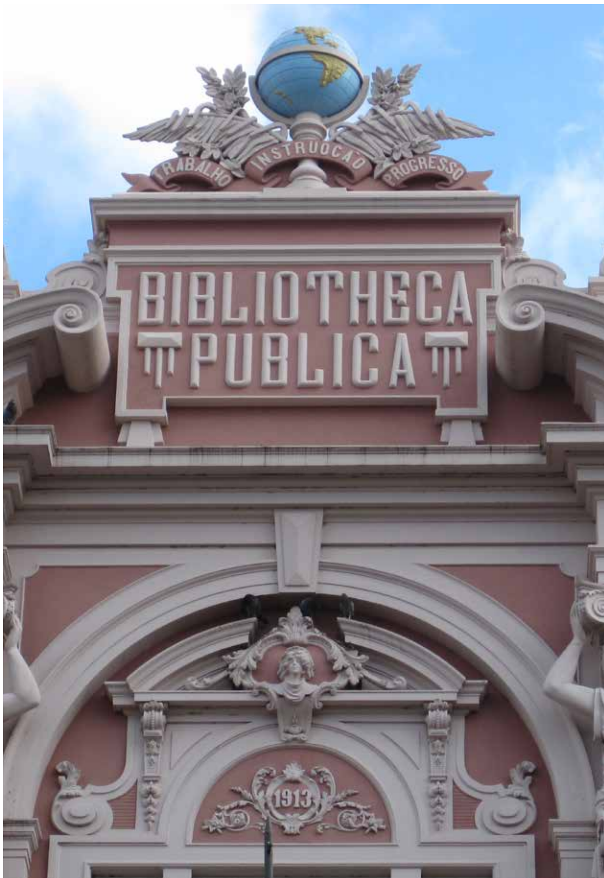
Figura 8 – Inscrições arquitetônicas na fachada da Bibliotheca Pública.
