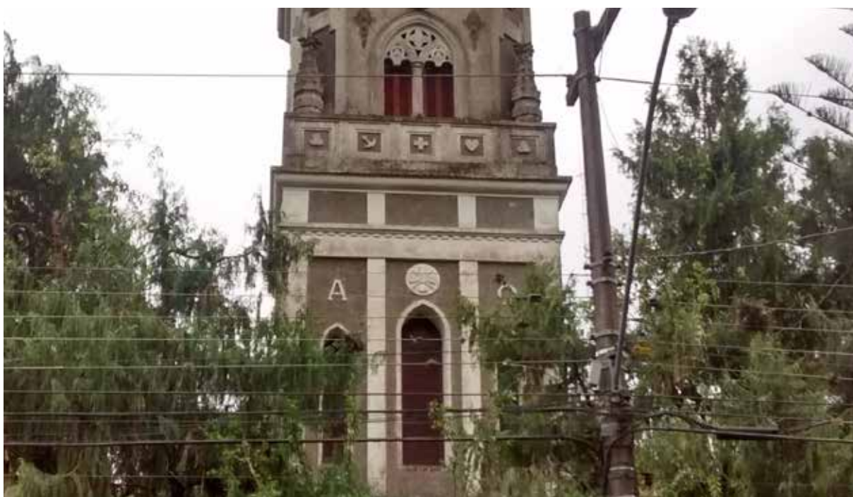
Figura 36 – Inscrições na torre da Igreja São João.
