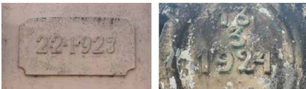
Figura 28 – Detalhe das inscrições nos imóveis localizados nas ruas Alberto Rosa, 304 (esquerda) e Antônio dos Anjos, 1148 (direita), com as datas de construção por extenso.
