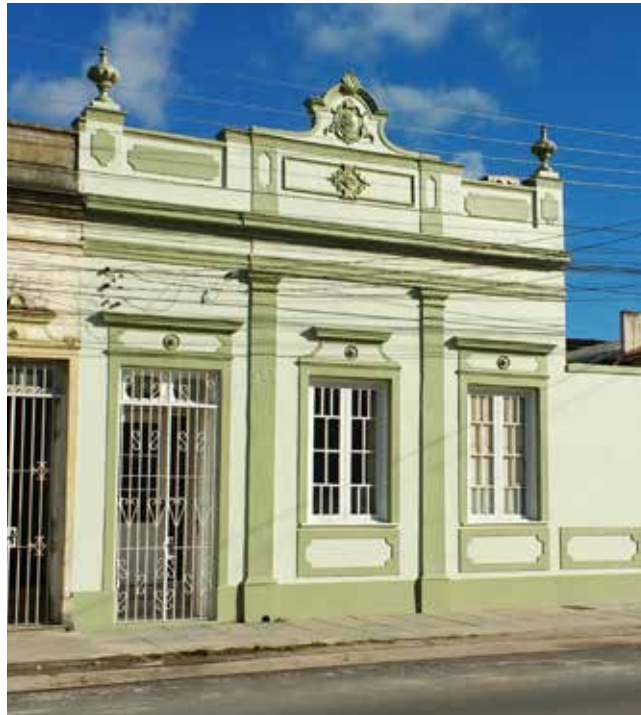
Figura 2 – Imóvel com três aberturas e frontão central na rua Conde de Porto Alegre, 253.
