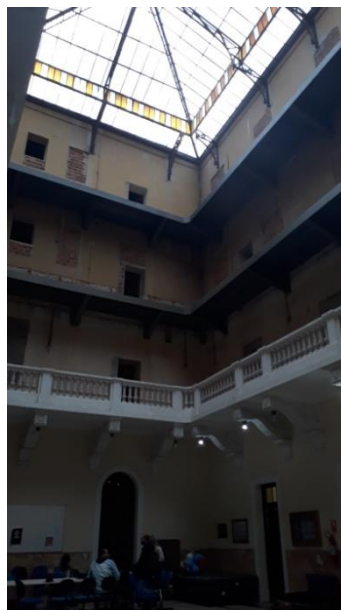
Figura 88 – Modificação da cobertura e as novas passarelas metálicas. Fonte: Acervo da autora, 2018.
