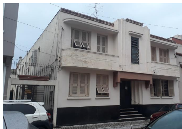
Figura 34 – Edifício multifamiliar, Pelotas/RS. Fonte: Acervo da autora, 2018.
