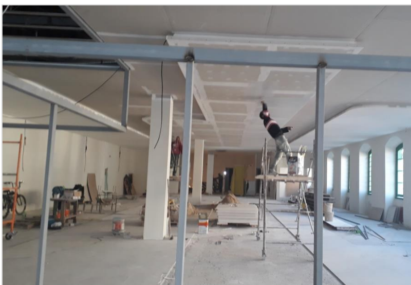
Figura 74 – O 'Casarão dos Mendonça' em obras em 2018. Fonte: Acervo da autora, 2018.
