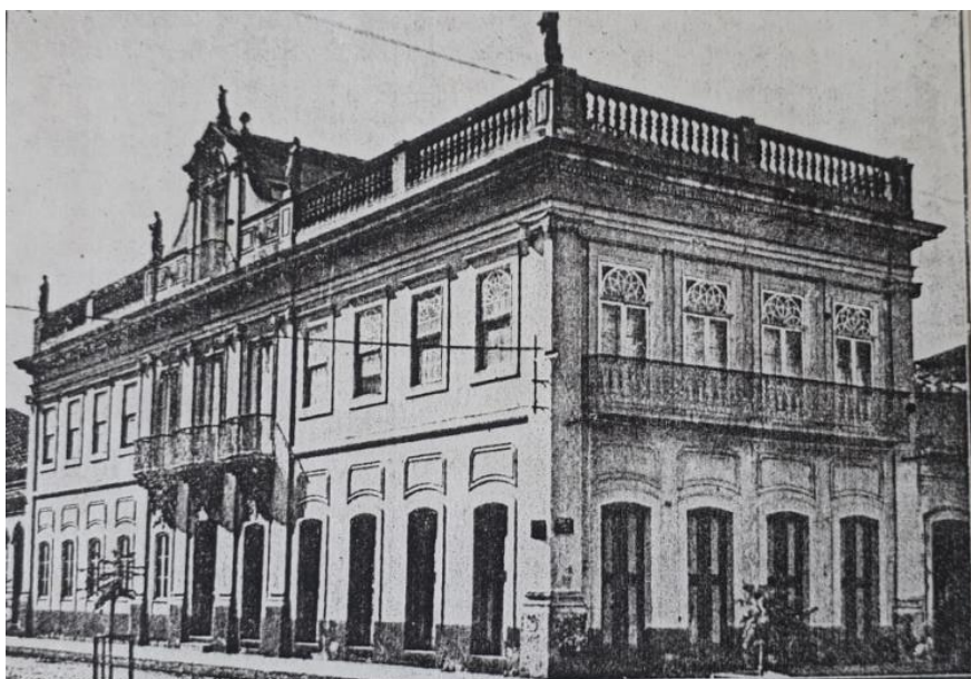
Figura 76 – Edificação em 1922. Destaque para as modificações dos vãos no segmento da esquina, no qual algumas portas foram transformadas em janelas. Fonte: SECULT, 2018.
