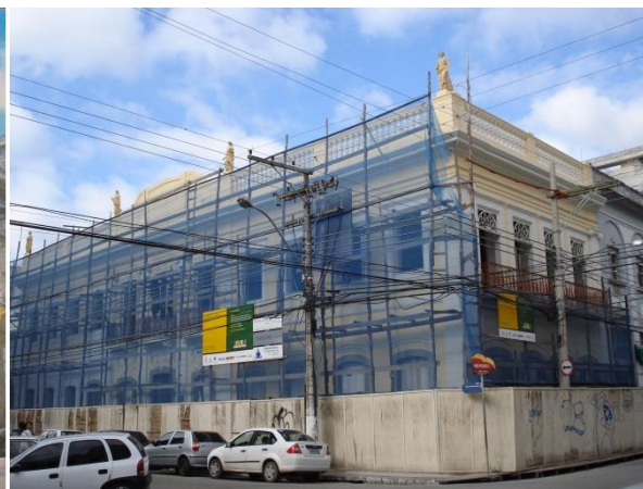
Figura 80 – Edificação em obras de restauro. Fonte: SANTOS, 2007.
