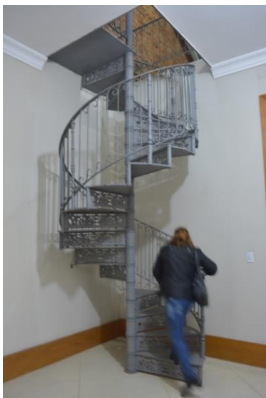
Figura 100 – Acesso cobertura da Casa 01. Fonte: Acervo da autora, 2018.
