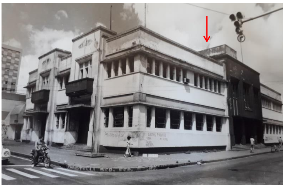
Figura 108 – A edificação em 1987. Destaque para o volume da caixa d'água. Fonte: SECULT, 1987. Modificada pela autora, 2019.
