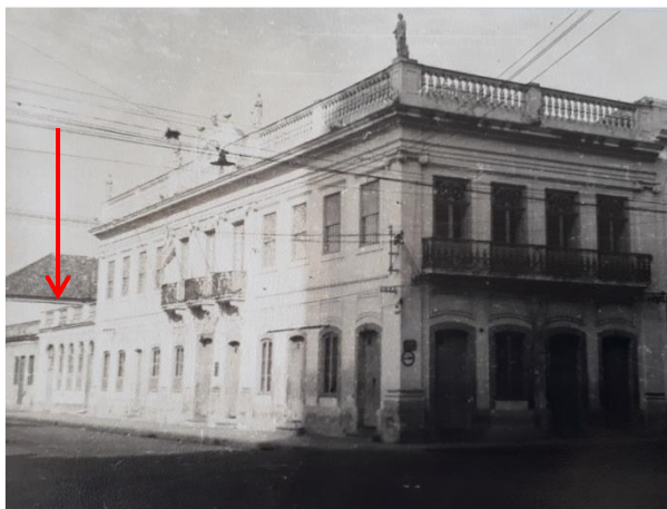
Figura 77 – Edificação em 1950. Destaque para o anexo construído e para as aberturas do térreo.
