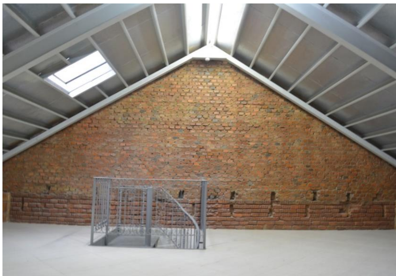
Figura 101 – As aberturas zenitais da cobertura da Casa 01. Fonte: Acervo da autora, 2018.
