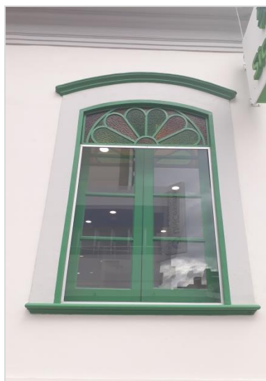
Figura 72 – Aberturas revitalizadas. Fonte: Acervo da autora, 2019.
