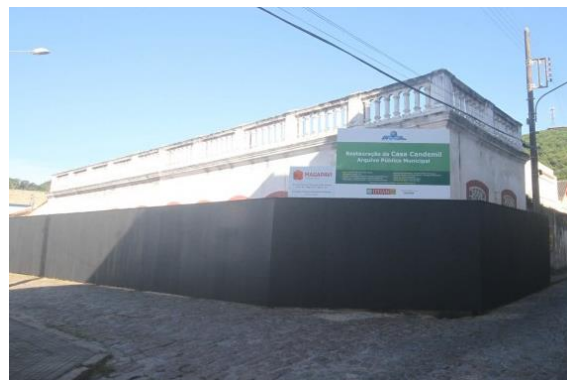
Figura 20 – 'Casa Candemil' em obras. Fonte: Acervo da autora, 2018.
