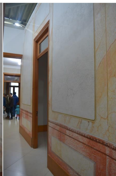
Figura 103 – Forro e escaiolas recuperados do vestíbulo e dos corredores da Casa 01. Fonte: Acervo da autora, 2018.
