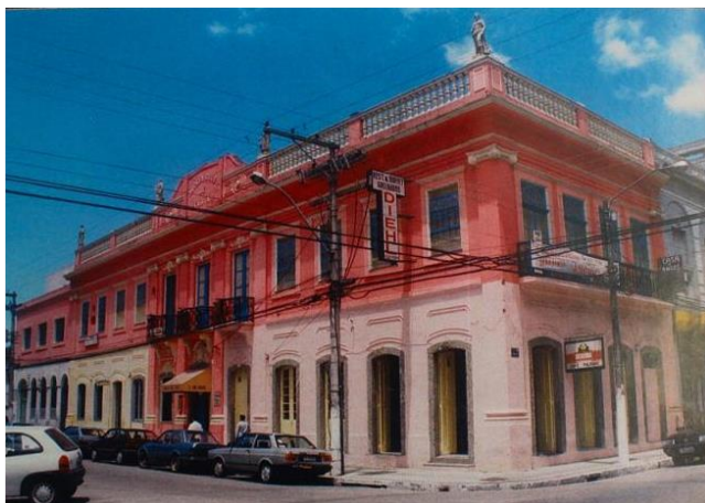
Figura 79 – Edificação no final da década de 1990. Fonte: SECULT, 2018.
