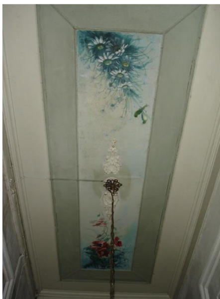
Figura 102 – Forro do vestíbulo da Casa 01. Fonte: SANTOS, 2006.
