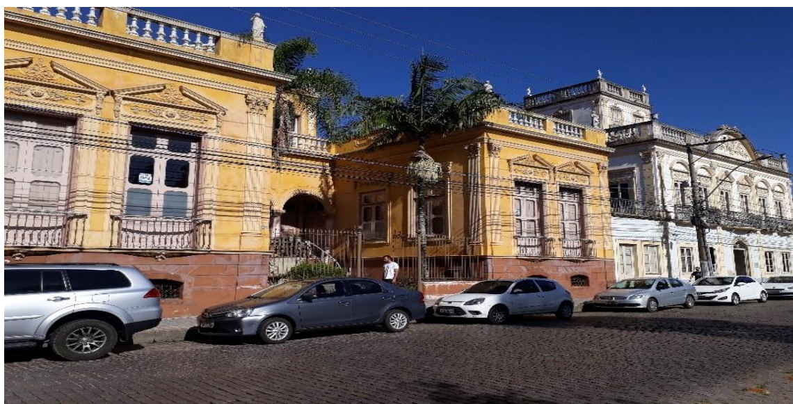
Figura 5- Residências do entorno da Praça Coronel Pedro Osório (casas 2, 6 e 8). Fonte: Fotografia do autor, 2018.
