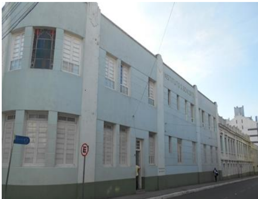
Figura 23- Imóvel privado 6. Endereço: Rua Félix da Cunha, n. 909. Fonte: Fotografia do autor, 2018.
