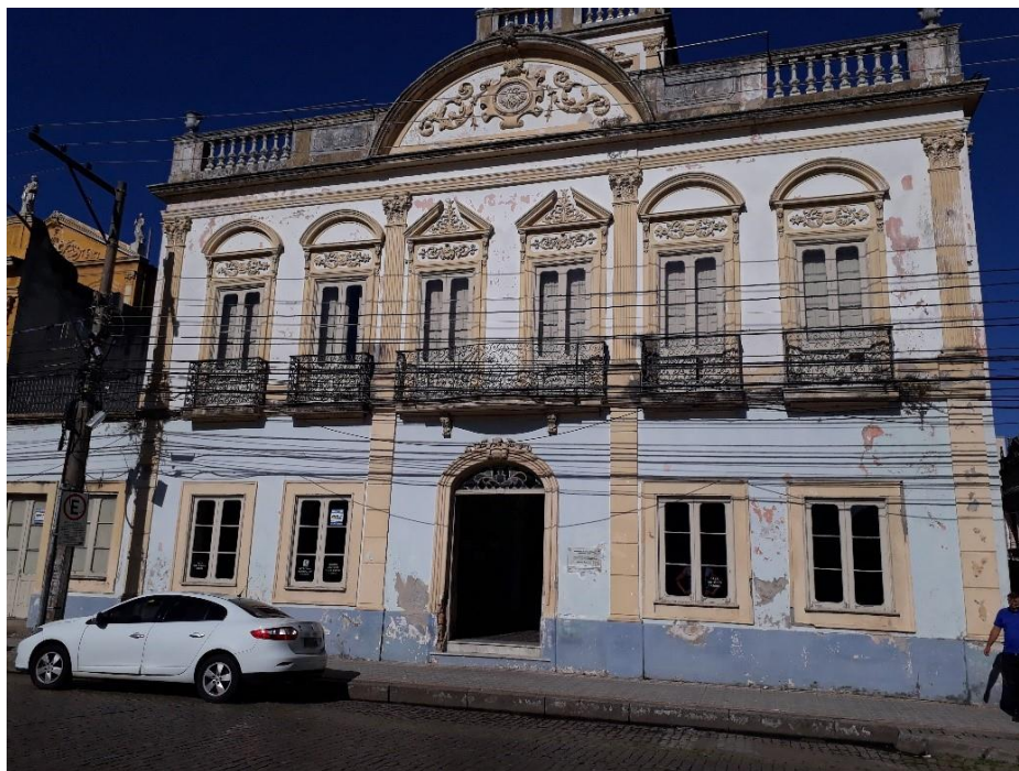
Figura 11- Casa 2. Fonte: Fotografia do autor, 2018.
