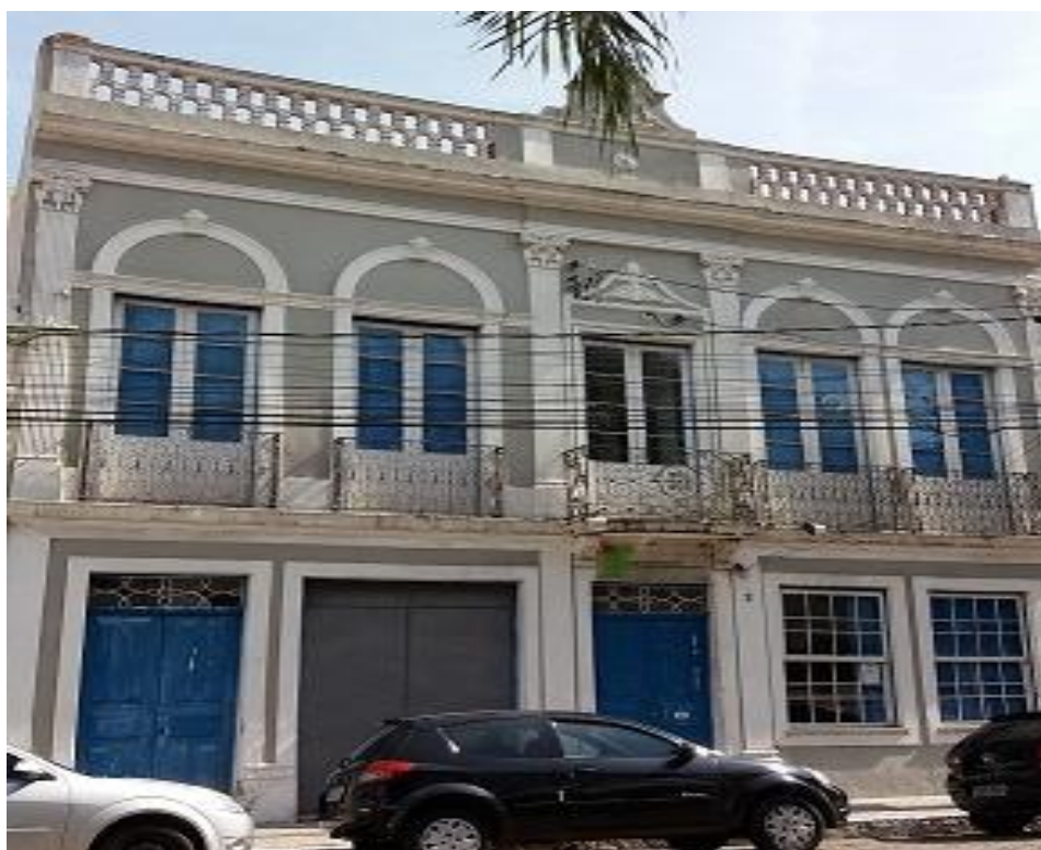
Figura 20- Imóvel privado 3. Endereço: Praça José Bonifácio, n. 3 e 5. Fonte: Fotografia do autor, 2018.
