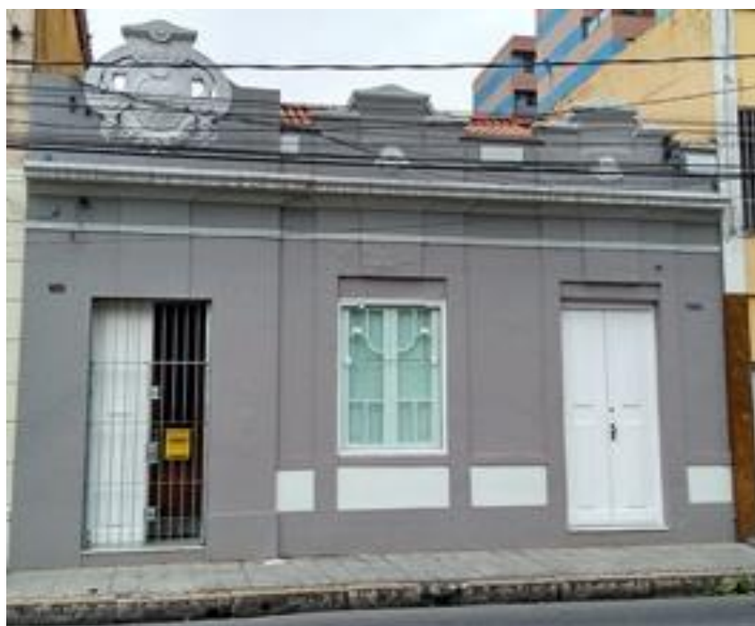
Figura 24- Imóvel privado 7. Endereço: Rua Félix da Cunha, n. 722. Fonte: Fotografia do autor, 2018.
