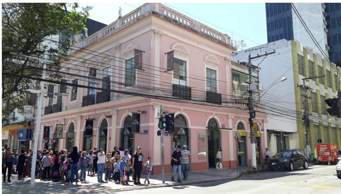
Figura 19- Imóvel privado 2. Endereço: Rua General Neto, n. 1006. Fonte: Fotografia do autor, 2018.
