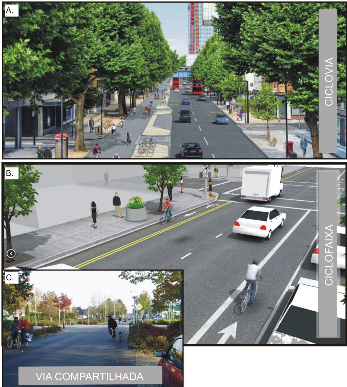
Figura 2.3 - Qualidades de infraestrutura cicloviária: ciclovia, ciclofaixa e via compartilhada; A) projeto de ciclovia da avenida Blackfriars em Londres, Reino Unido; B) ciclofaixa no contra fluxo dos automóveis em via de mão única combinada com ciclofaixa convencional; C) exemplo de via local de baixo fluxo com compartilhamento entre ciclistas e veículos.
