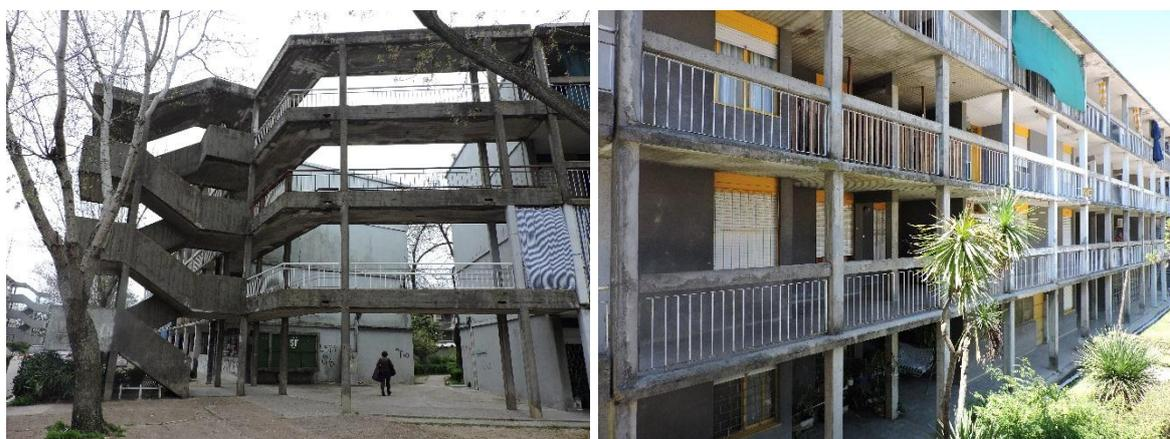
Figura 125: “Infraestrutura” do conjunto: circulações verticais, passarelas e circulações horizontais externas.
