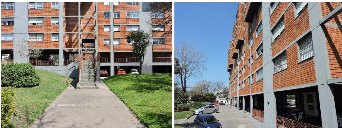
Figura 46: Edifício B. À esquerda, circulação horizontal externa e pavimento inferior com pilotis, apenas em metade do edifício. À direita, continuação da circulação horizontal externa que se transforma em pavimento térreo. Fonte: Fotografias de C. Ritter, 2018.
