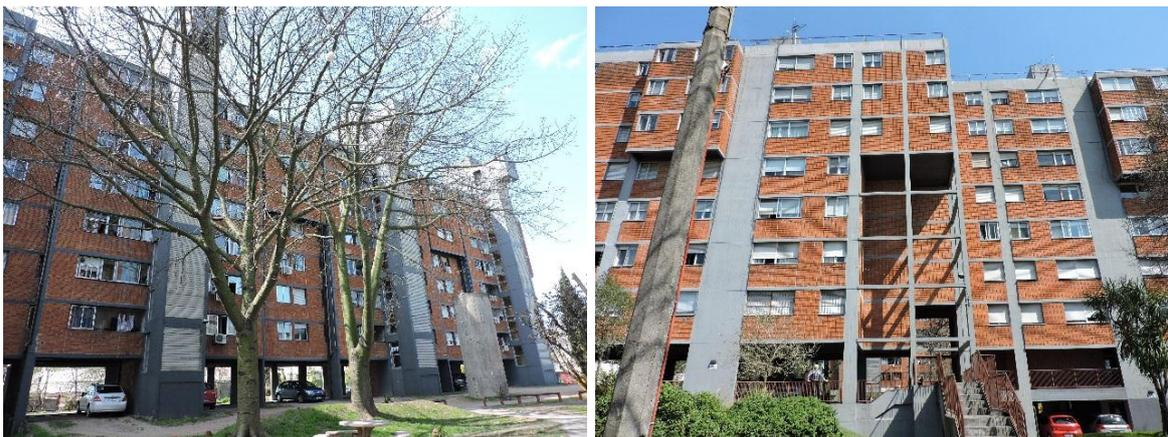
Figura 75: Torres de circulação vertical no volume dos edifícios. À esquerda, uma das fachadas internas do conjunto, à direita, fachada voltada ao entorno. Fonte: Fotografias de C. Ritter, 2018.
