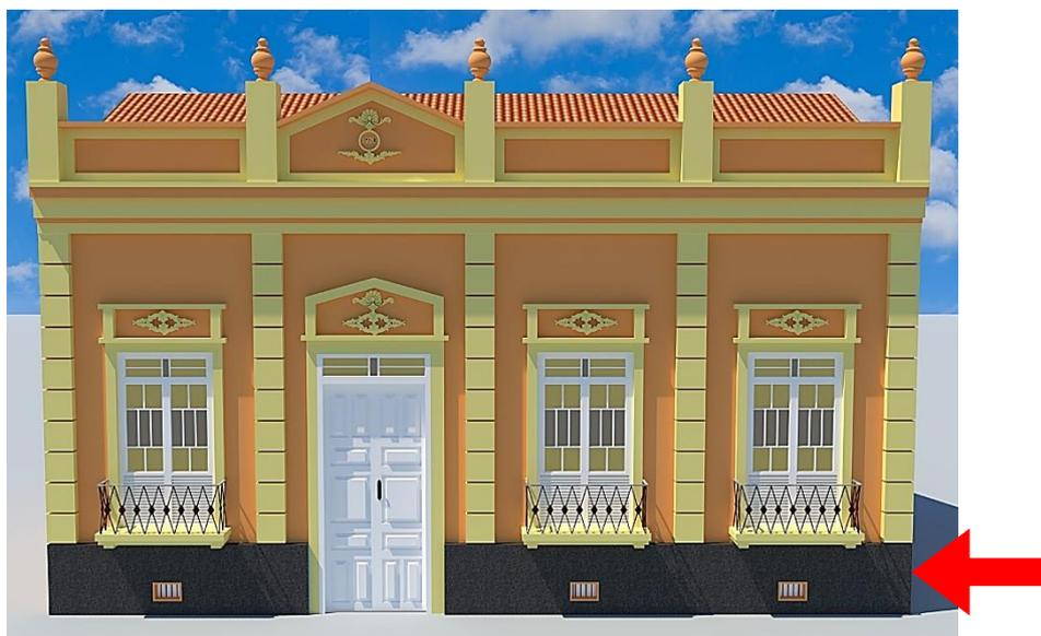
**Figura 43** – Ilustração de possibilidade de acréscimo de revestimentos (irreversível).
