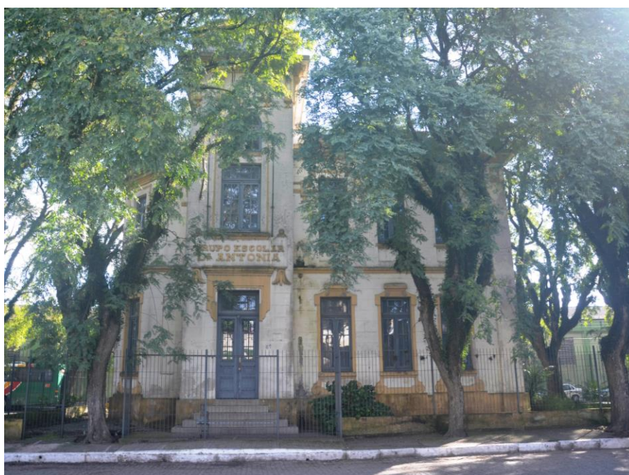
Figura 119 Fotografia da fachada principal do D. Antonia, 2018 Fonte: Acervo da autora.
