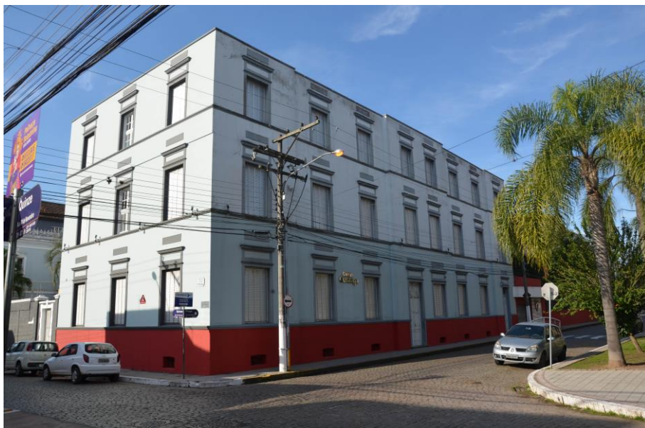
Figura 59 Fotografia do edifício do Gonzaga 2018 Fonte: Acervo da autora.
