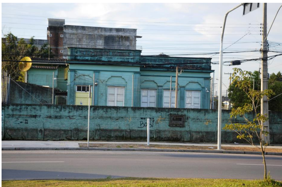
Figura 95 Fotografia da fachada principal do Mariana Eufrásia, 2018 Fonte: Acervo da autora.
