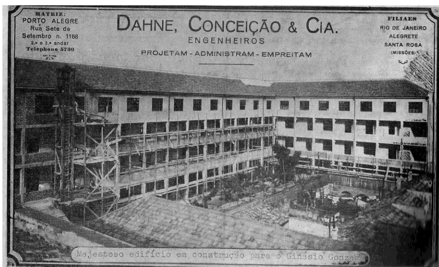
Figura 56 Fotografia da construção do pavilhão da rua Anchieta do Gonzaga Fonte: Lembranças, 1939. Acervo da autora.
