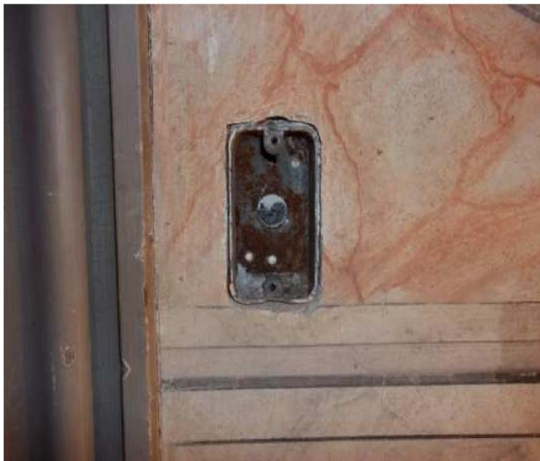
Figura 05 – Colocação de tomadas em uma das paredes com escaiolas. Intervenção feita no casarão em uma das ocupações.
