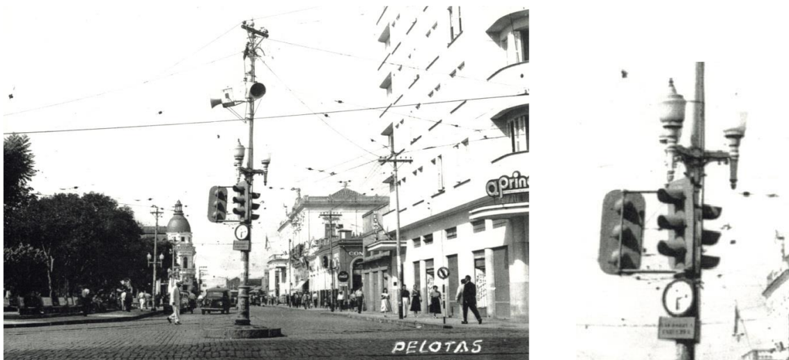
Figura 17: Fotografia com poste localizado na Praça Cel. Pedro Osório, na esquina com a Rua XV de Novembro (à esquerda) e de uma ampliação nas luminárias semelhantes ao modelo PEL/16-0004 (à direita).
