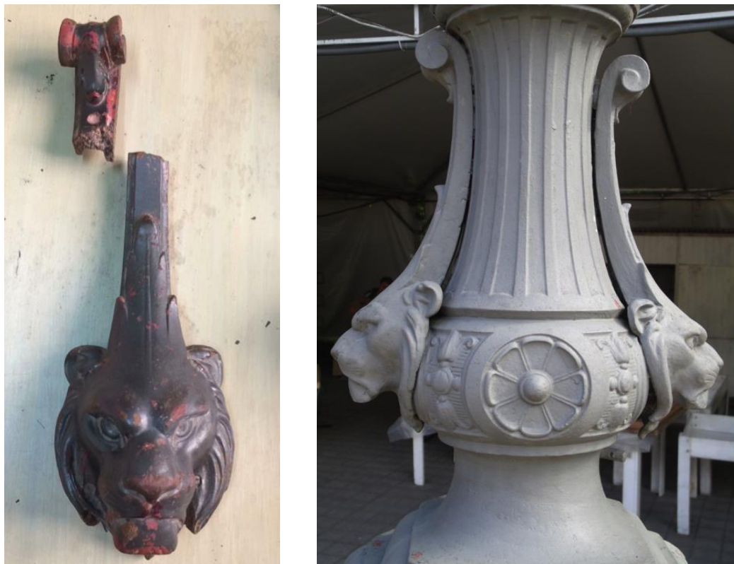
Figura 42: Imagem do leão fraturado (à esquerda) e a diferença de tamanho encontrada entre os leões originais (maiores) e os substitutos (à direita).
