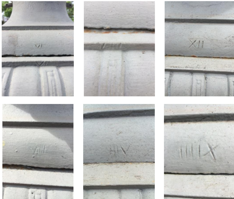
Figura 39: Marcas individuais usadas provavelmente para montagem dos postes.
