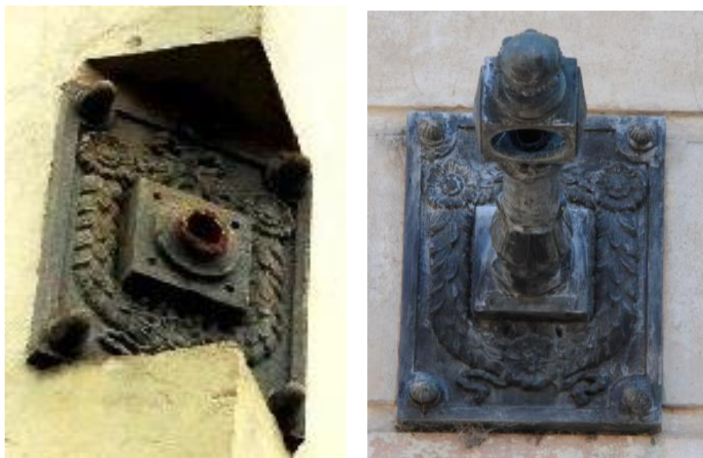
Figura 13: Base de sustentação de tocheiro modelo PEL/16-0002 (à esquerda); base e suporte de tocha de modelo PEL/16-0002 (à direita).
