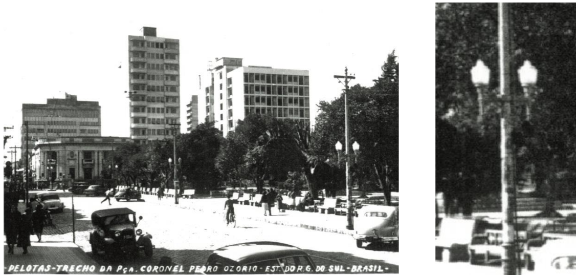
Figura 18: Fotografia de postes de iluminação do entorno da Pça. Cel. Pedro Osório (à esquerda) e de uma ampliação nas luminárias semelhantes ao modelo PEL/16-0004 (à direita).
