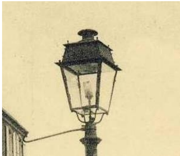
Figura 5: Válvula reguladora da passagem de gás (à esquerda); luminária de época com haste facilitando o manuseio (à direita).
