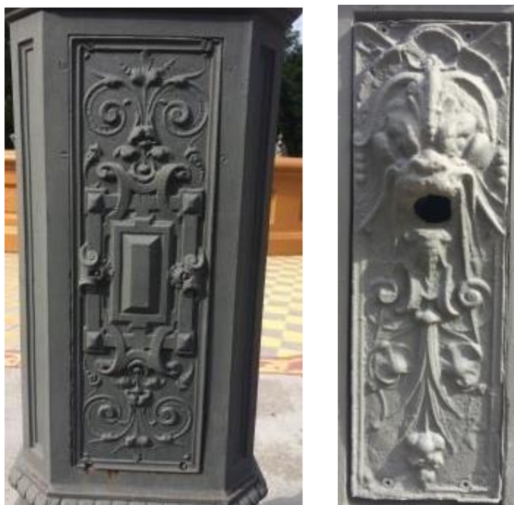
Figura 44: Imagens mostrando variação de textura e de tamanho entre a tampa frontal com gárgula e a tampa traseira do poste.
