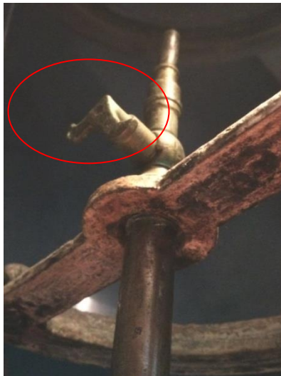
Figura 5: Válvula reguladora da passagem de gás (à esquerda); luminária de época com haste facilitando o manuseio (à direita).
