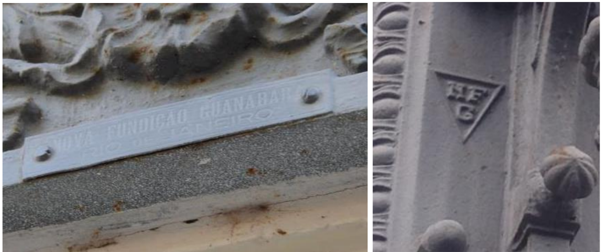
Figura 22: Plaqueta com indicação do fabricante encontrada em luminária PEL/16-0002 e PEL/16-0005, à esquerda. Marcas em relevo com indicação do fabricante encontradas em modelo luminária PEL/16-0003, à direita.
