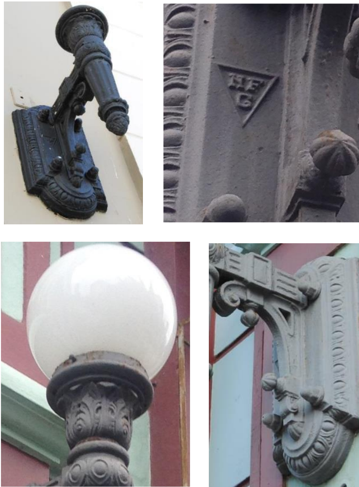
Figura 15: Imagem de tocheiro modelo PEL/16-0003 (imagem superior à esquerda), e de um detalhe do fabricante de logotipo em relevo (imagem superior à direita), de detalhe de suporte para encaixe do globo de vidro (imagem inferior à esquerda) e de detalhe do reforço.
