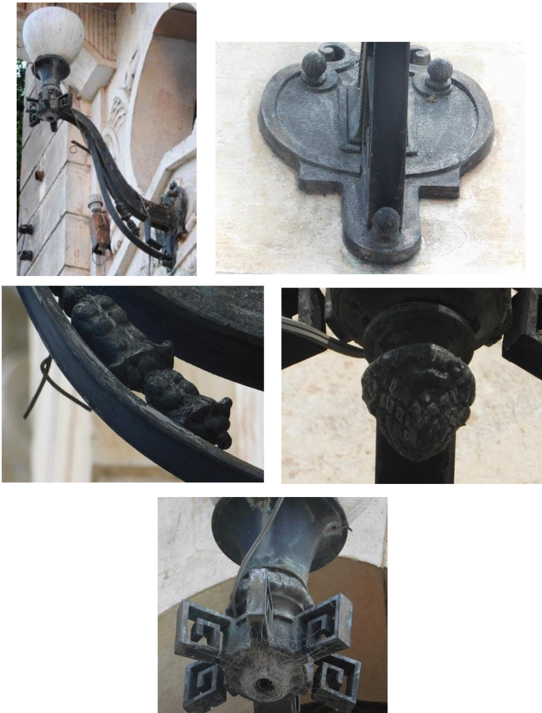
Figura 19: Imagem de tocheiro modelo PEL/16-0005 (imagem superior à esquerda), de um detalhe da base de sustentação (imagem superior à direita), de detalhe dos chambranles ou borlas (imagem central à esquerda), de arremate com pinha (imagem central à direita) e de espirais gregas (imagem inferior).
