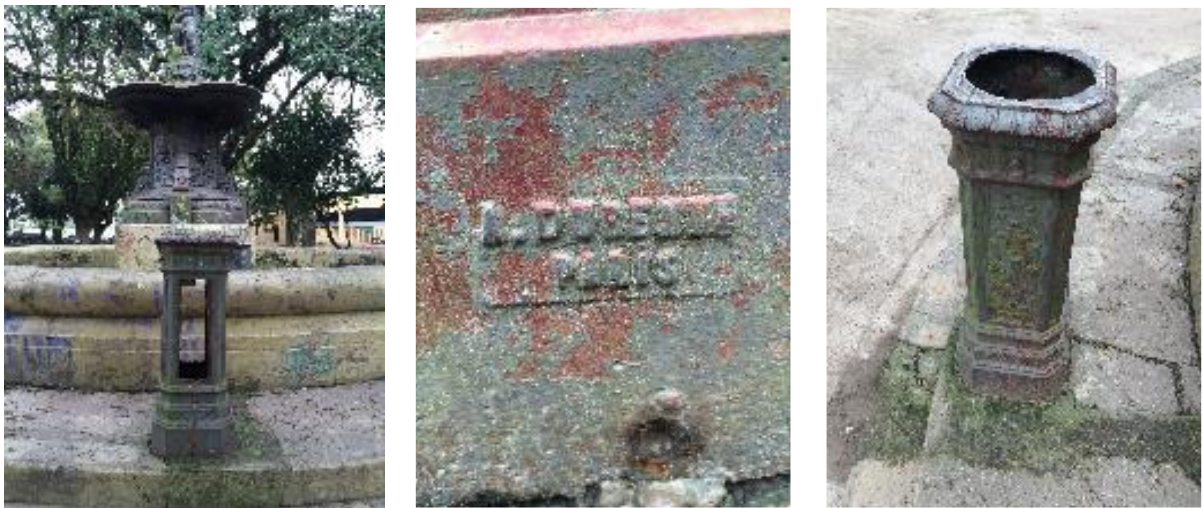
Figura 12: Base de poste com lacunas (à esquerda); marca de fabricante em alto relevo (ao centro); base de poste aparentemente completa (à direita).
