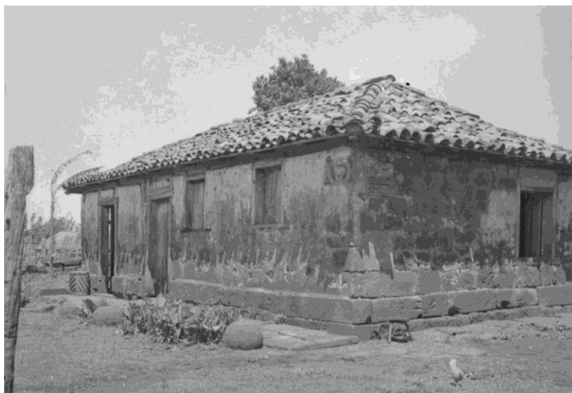
Figura 38: Casa de material missioneiro em São João Batista. Novembro de 1937.
