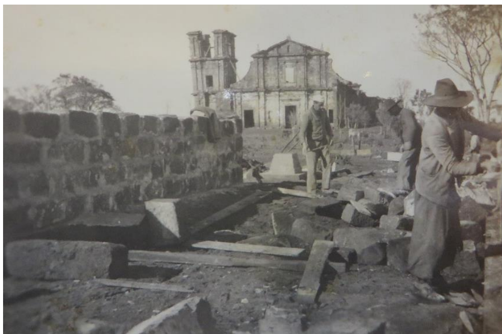
Figura 41: Operários trabalhando na construção do Museu.
