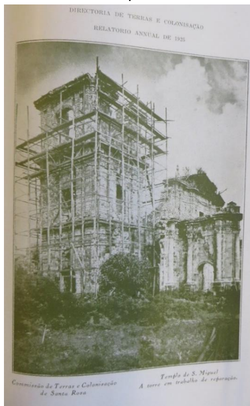
Figura 36: Reprodução de fotografia das obras nas ruínas em 1925
