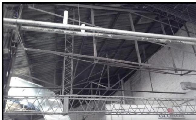
Figura 31 - Muros de ladrillo expuestos dentro del taller de carenados de vehículos. Archivo Personal, 16/08/2018. Figura 32 - Escudras y techo con chapa de zinc del taller de carenados de vehículos. Archivo Personal, 16/08/2018
