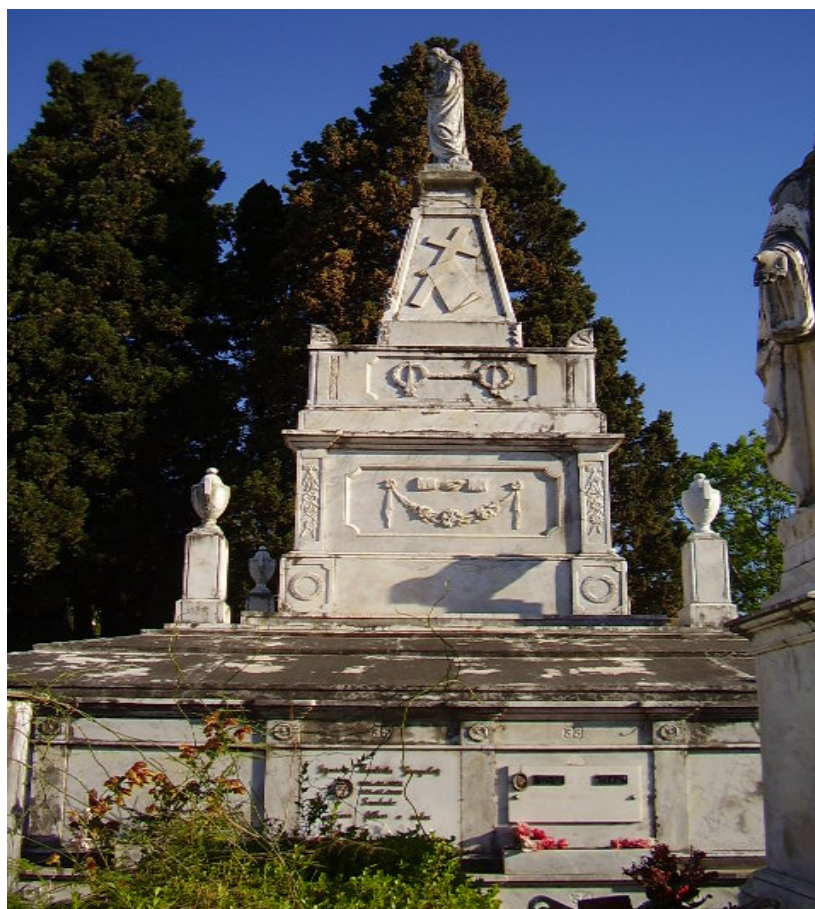
Figura 27: Panteón da Sociedade Espanhola de Bagé.
