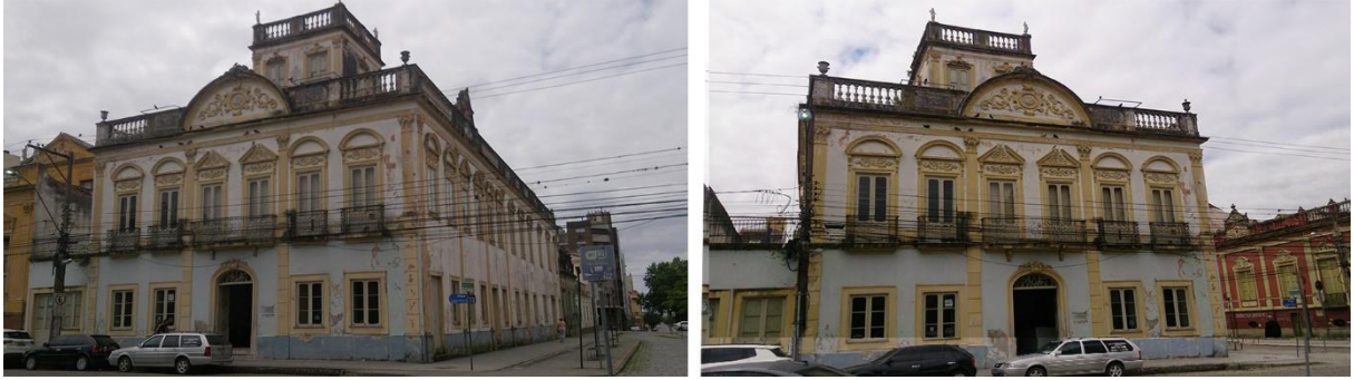
Figura 15 - Estado atual do Casarão 2 Fonte: Autora (2019)
