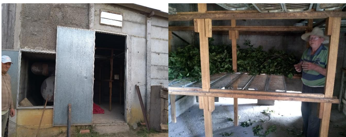
Figura 41 – Propriedade em São Lourenço do Sul. Estufa de fumo, vista frontal (à esquerda); vista interna (à direita), onde se pode ver as grelhas para suporte das folhas (2019). Fonte: Acervo da autora.
