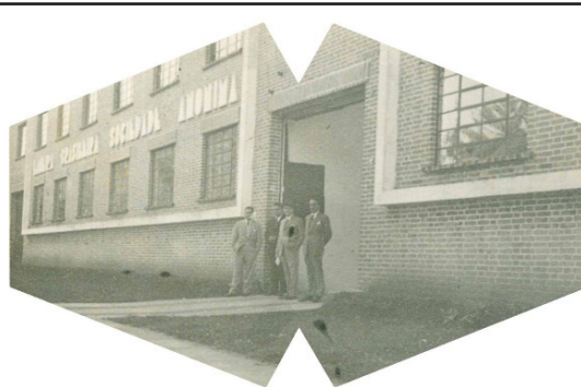
Fototeca Memória da UFPel - Coleção Laneira S.A - Vista parcial da fachada.
