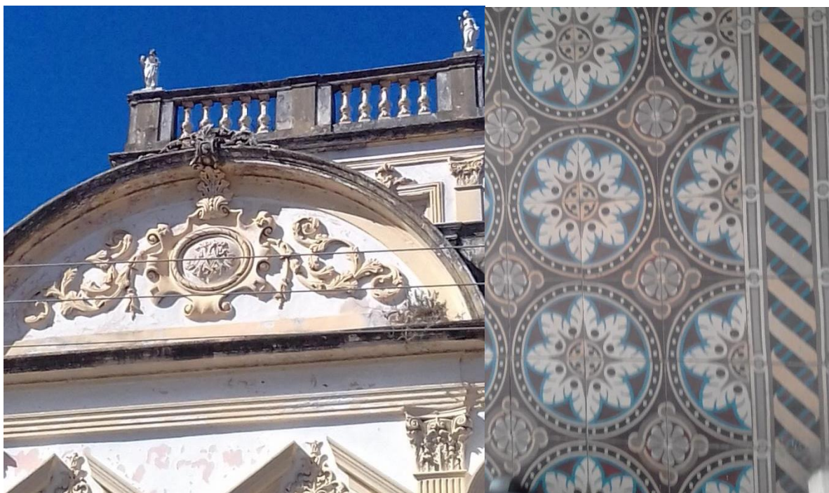
Figura 29 - À esquerda, fachada do casarão; à direita, piso do hall de entrada. Fonte: ACERVO PESSOAL, 2019.
