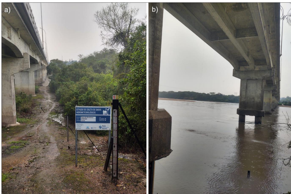
Figura 28 – a) Réguas linimétricas de monitoramento fluviométrico do rio Camaquã, da seção de controle Passo do Mendonça; b) seção de controle com vistas da largura do rio Camaquã, município de Cristal (RS).
