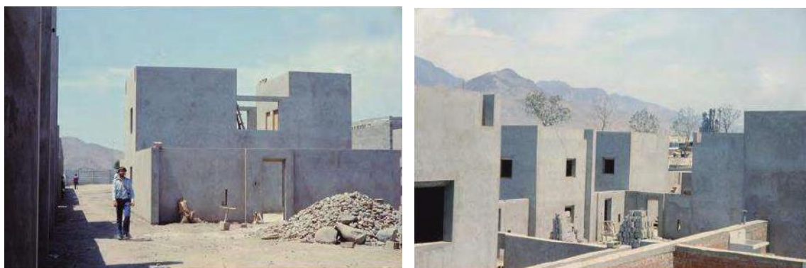
Figura 156 – a) Poucas fenestrações nas fachadas; b) Vista das fenestrações das fachadas. Agrupamento Experimental (construído).
