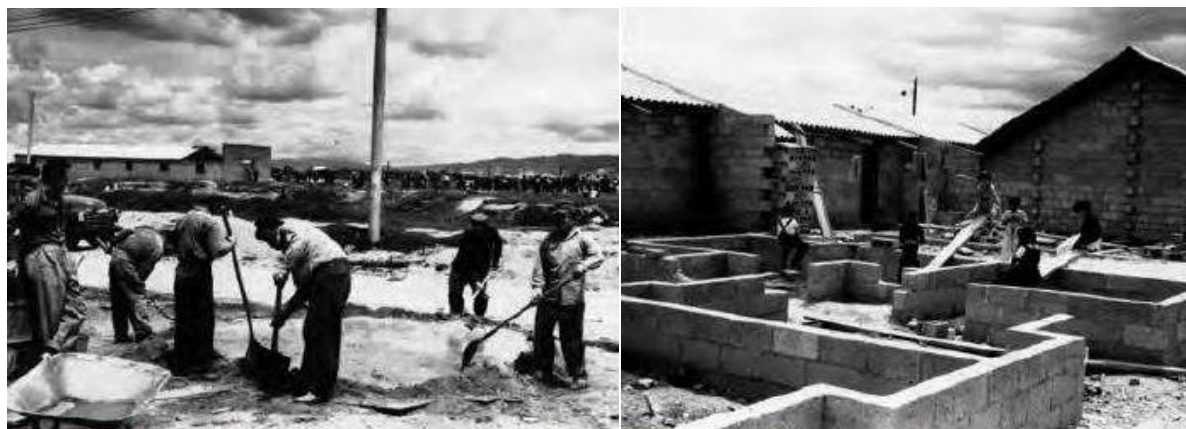
Figura 62 – a) Futuros moradores trabalhando na construção da urbanização; b) Crianças das famílias no canteiro de obras.
