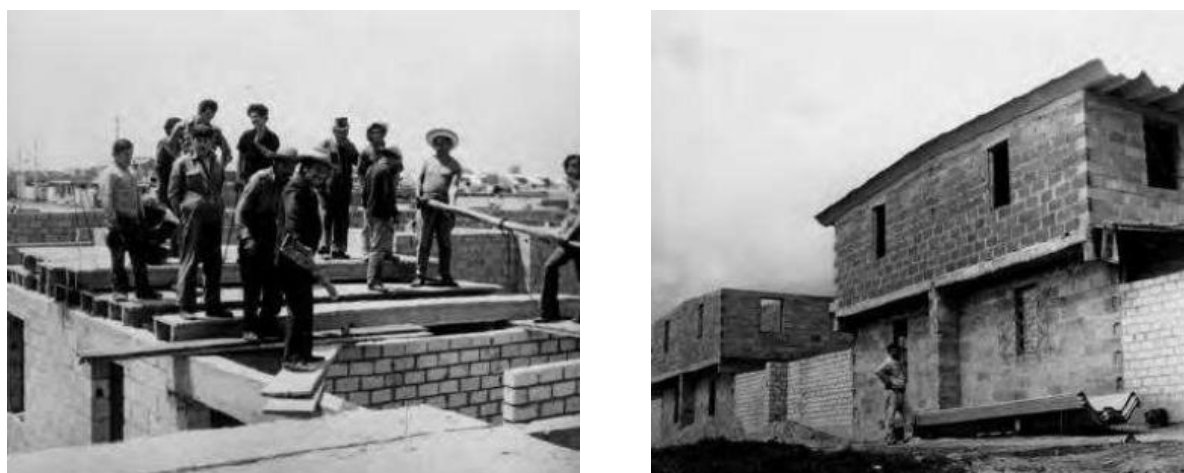
Figura 114 - a) Equipe de autoconstrução dirigida; b) Construção do segundo pavimento das habitações. Fonte: O'BYRNE OROZCO e ÁNGEL SAMPER, 2012, p. 125.
