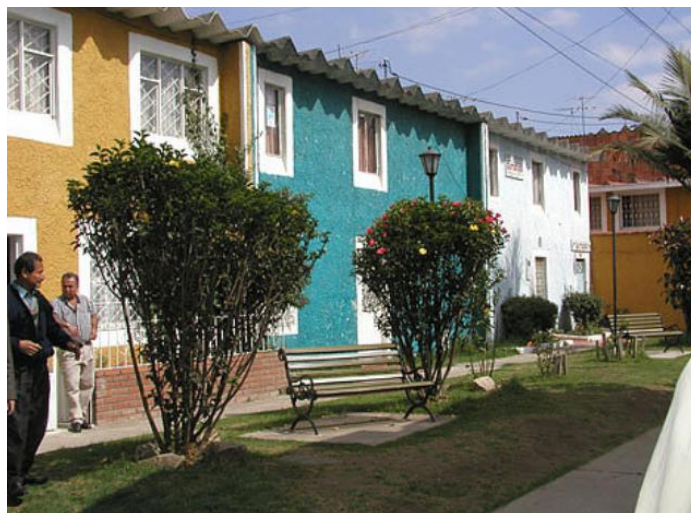
Figura 121 – Fachadas argamassadas, coloridas e com aberturas destacadas.
