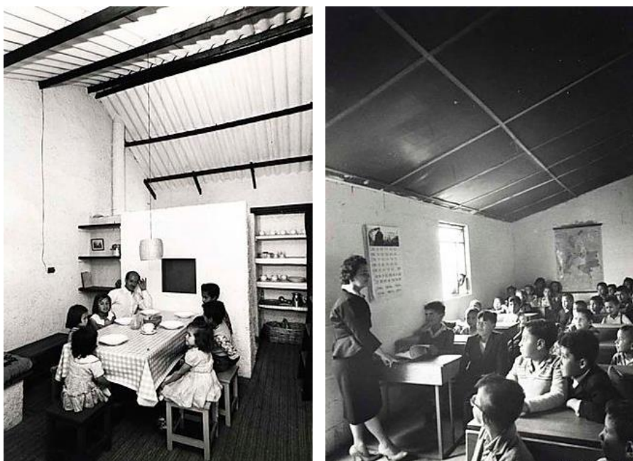
Figura 81 – a) Paredes internas chapiscadas e pintadas, sem forro no teto; b) Espaço produtivo usado como sala de aula apresentava paredes rebocadas e pintadas, com forro no teto.
