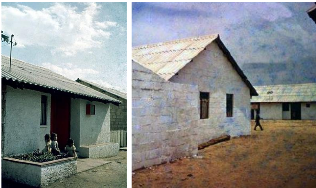
Figura 80 – a) Fachada principal rebocada e pintada; b) Fachada lateral com pintura sobre o tijolo aparente.
