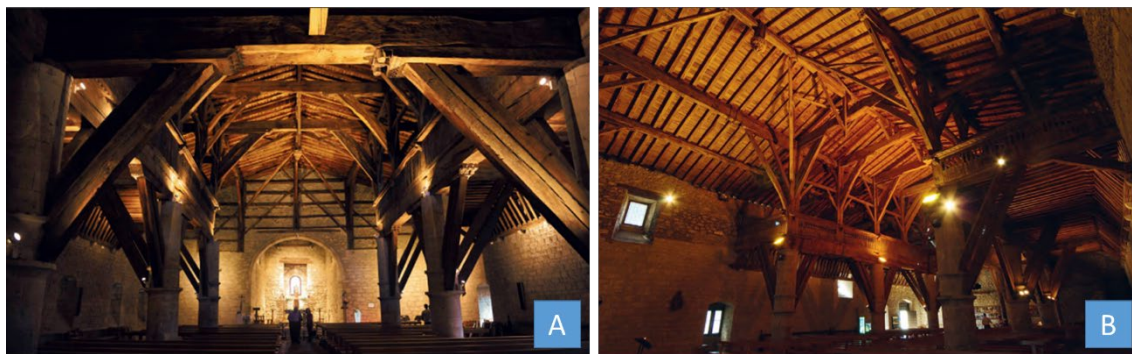
Figura 31 — A — Vista interior axial das naves em direção à cabeceira do templo. B — Triangulação das diagonais de madeira ( jabalcones ) insinua a curvatura de abóbodas.
