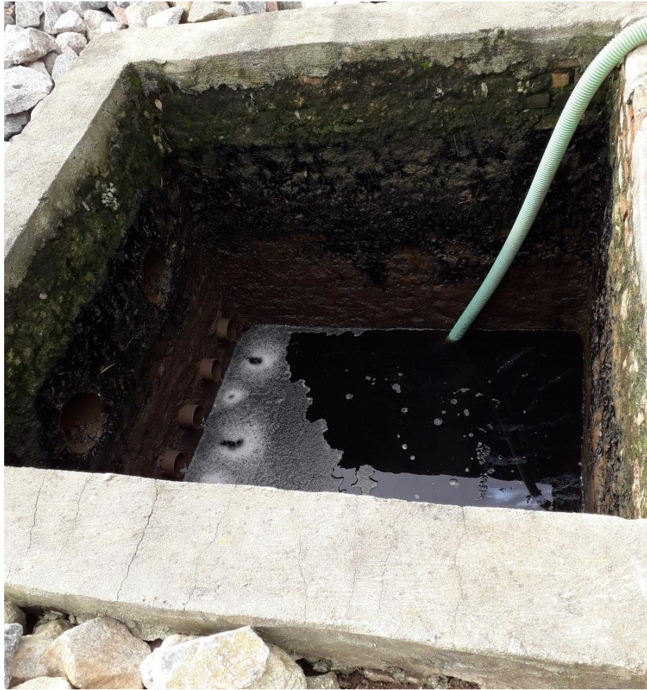
Figura 3 – Ponto de coleta da amostra de lixiviado bruto
