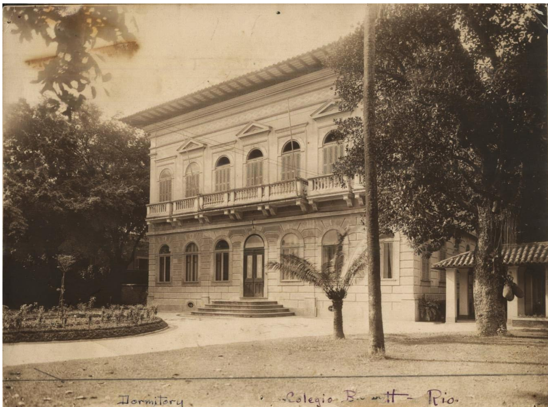
Figura 4 – Prédio do Colégio Bennett.
