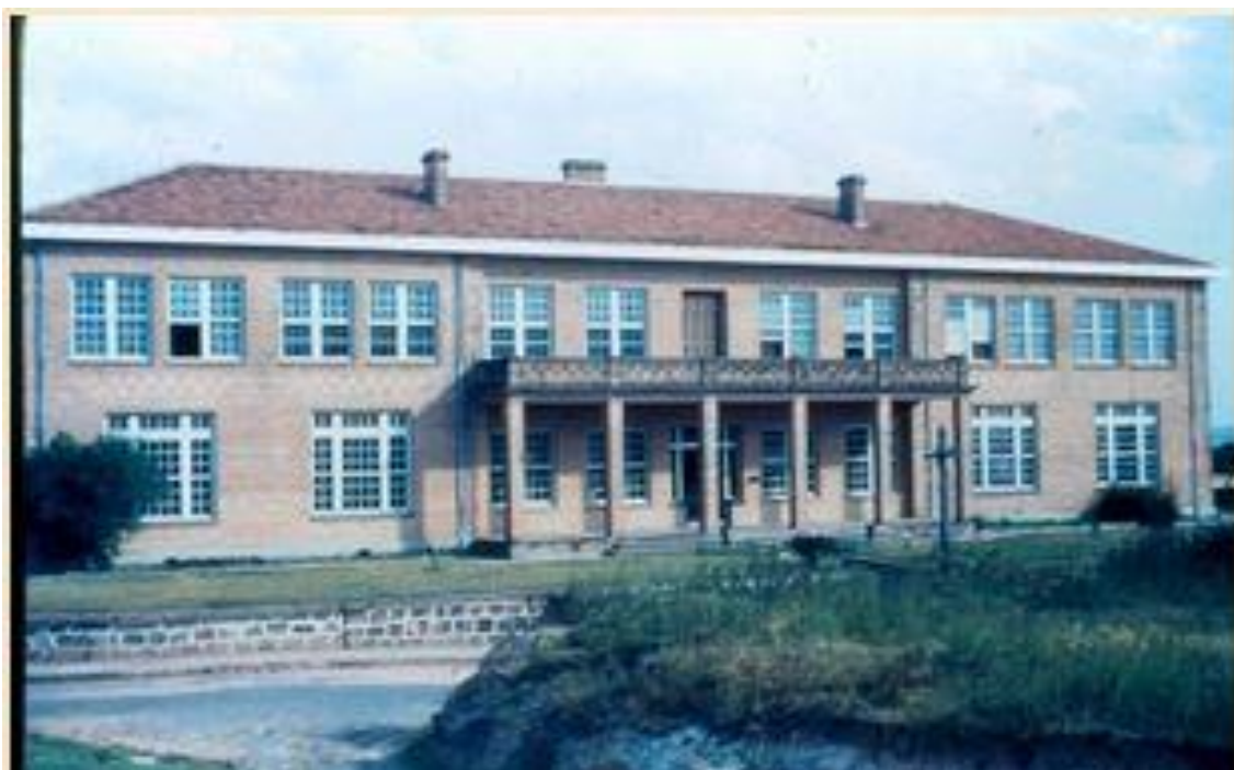
Figura 7 – Prédio do Colégio Centenário.
