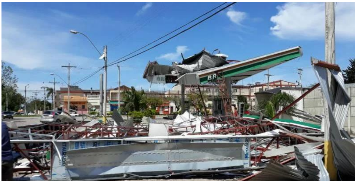
Figura 18: O posto de combustíveis com o telhado arrancado pela força do vento. Pelotas 29/09/2018.
