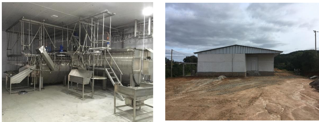
Figura 13 - Abatedouro-frigorífico de aves em construção
