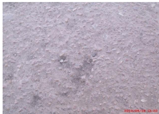
Figura F.0.5- Detalhe do piso cimentado
