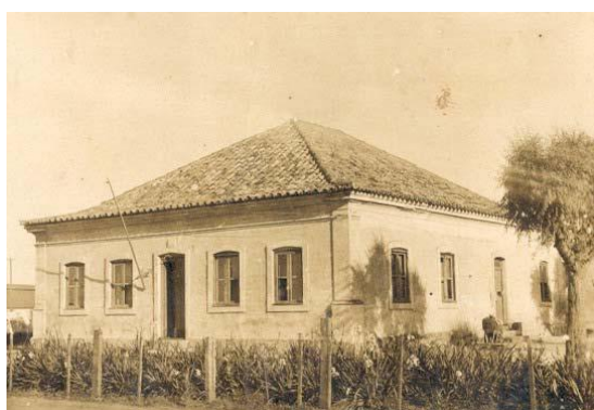
Figura 3.14 - Sede da charqueada Fonte PMP/Seurb, 1914
