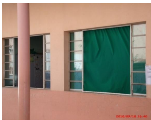
Figura 3.21 - Esquadrias Bloco E
