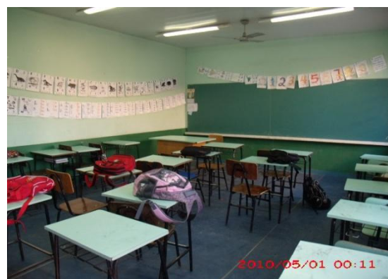
Figura F.0.9- Sala de aula, Bloco E, piso cerâmico
