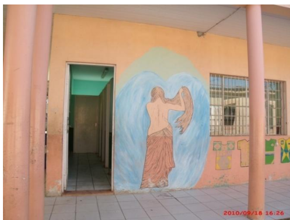
Figura F.0.2- Parede externa do Wc
