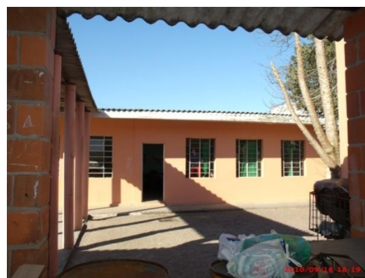
Figura 3.7 - Vista externa Blocos F e G
