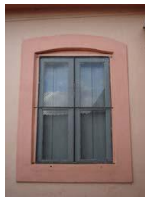
Figura 3.22 - Esquadrias Bloco A
