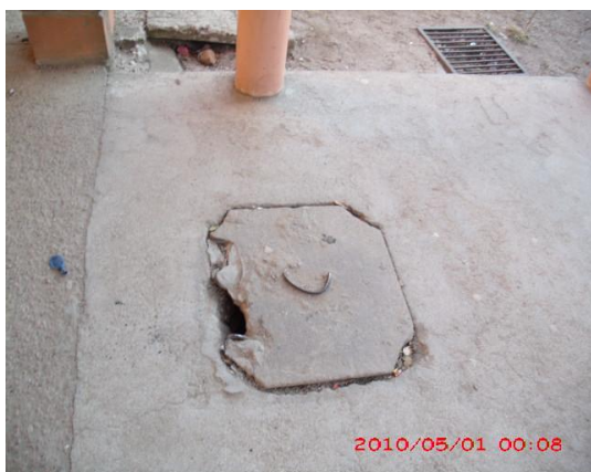
Figura F.25 - Piso do pátio coberto
