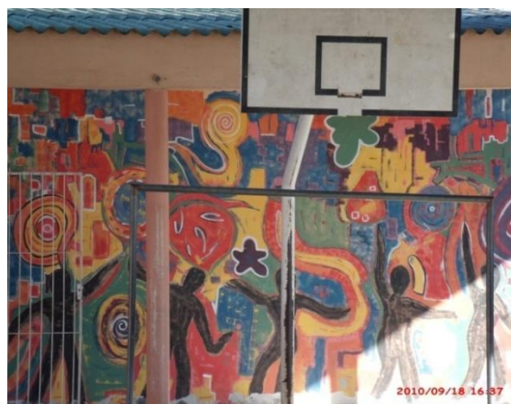
Figura F.0.3- Parede externa - Bloco F.
