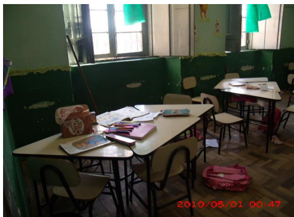
Figura F.0.17- Sala de aula, Bloco A
