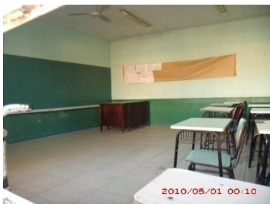
Figura F. 0.14- Sala de aula Bloco B, cores internas
