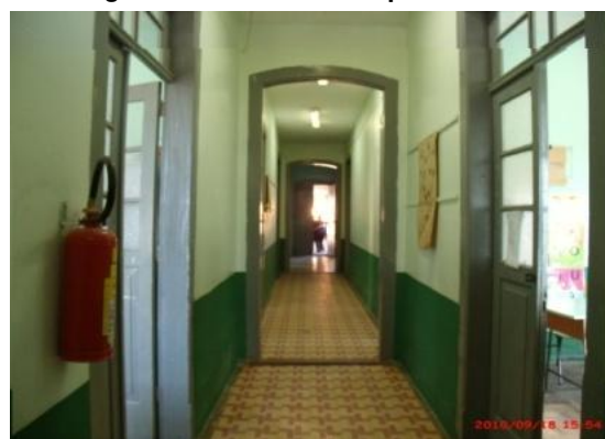
Figura F. 0.7- Circulação Bloco A, piso de ladrilho hidráulico
