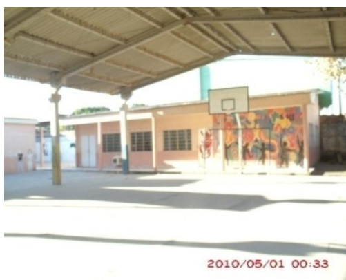
Figura 3.6 - Vista externa Bloco B
