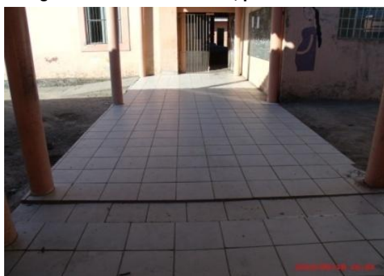
Figura F.0.6- Circulação interna, piso cerâmico
