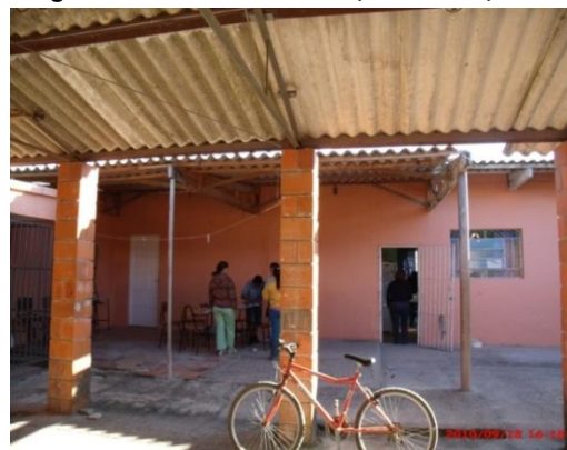
Figura 3.13 - Vista externa, Bloco E
