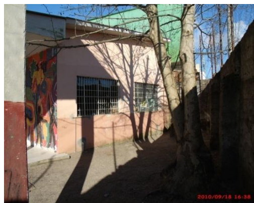
Figura 3.9 - Pátio coberto e vista Bloco C
