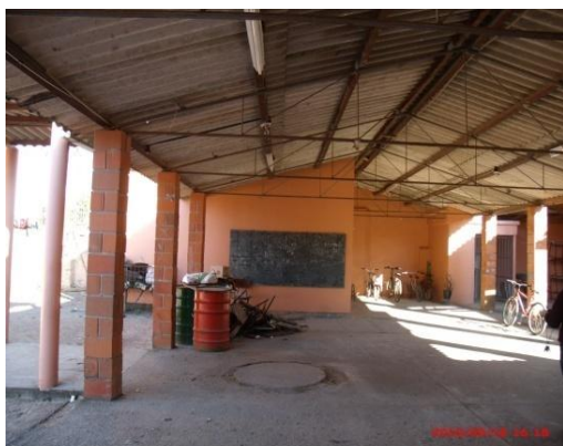
Figura 3.8 - Pátio dos fundos, Bloco F
