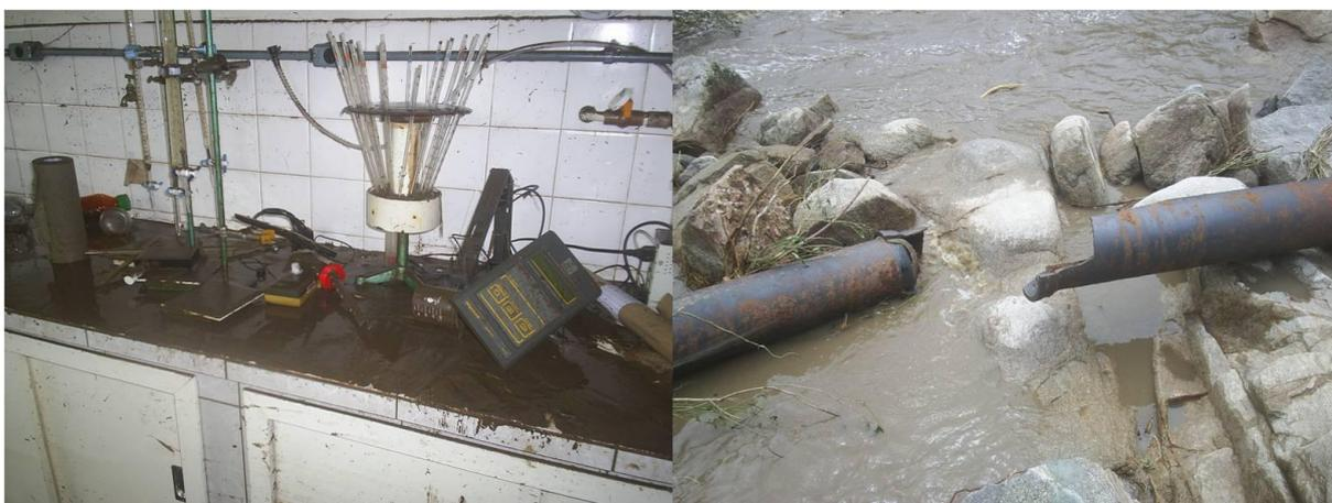
Figura 12 -Laboratórios e canos danificados da ETA Moreira após o evento de precipitação extrema de janeiro de 2009
