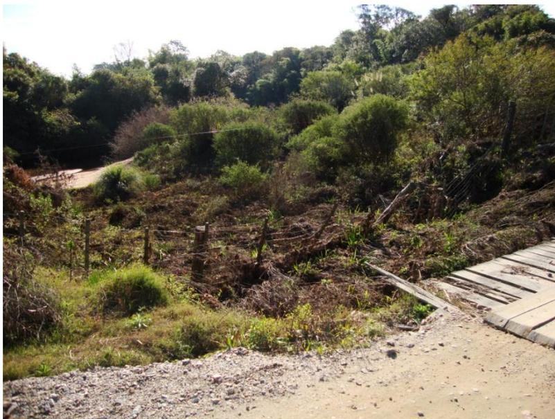
Figura 15 -Desvio do curso original de passagem do escoamento das chuvas na bacia de contribuição da estação Passo dos Carros
