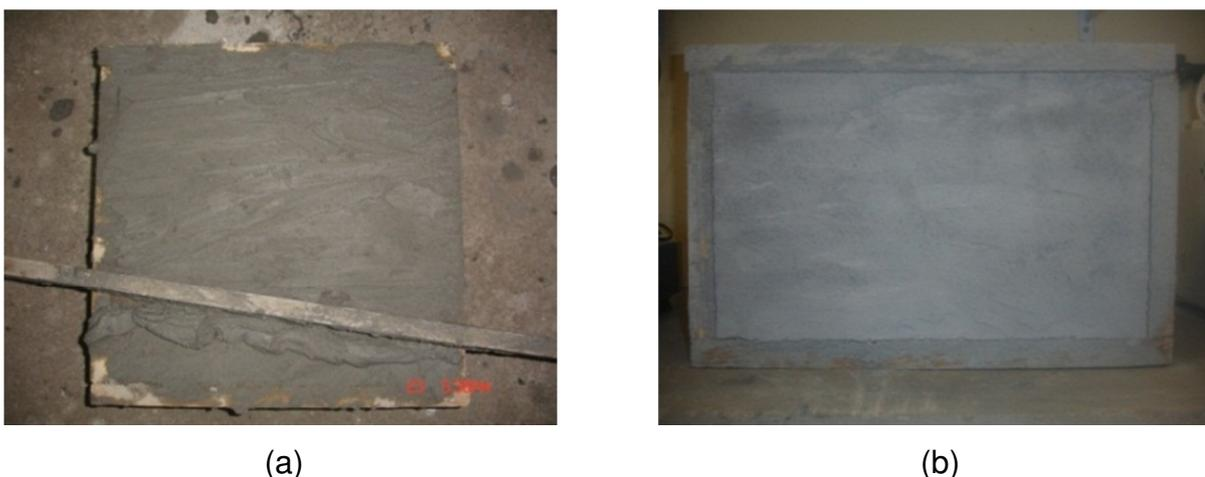
Figura 21 - Aplicação da argamassa de revestimento no substrato (a) execução; (b) revestimento pronto.
