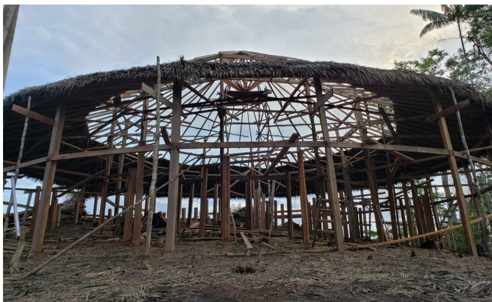
Figura 15 - Detalhe da palha da cobertura
