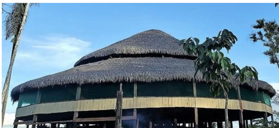
Figura 18 – Shuhu em fase de finalização (com as telas de proteção para insetos).
