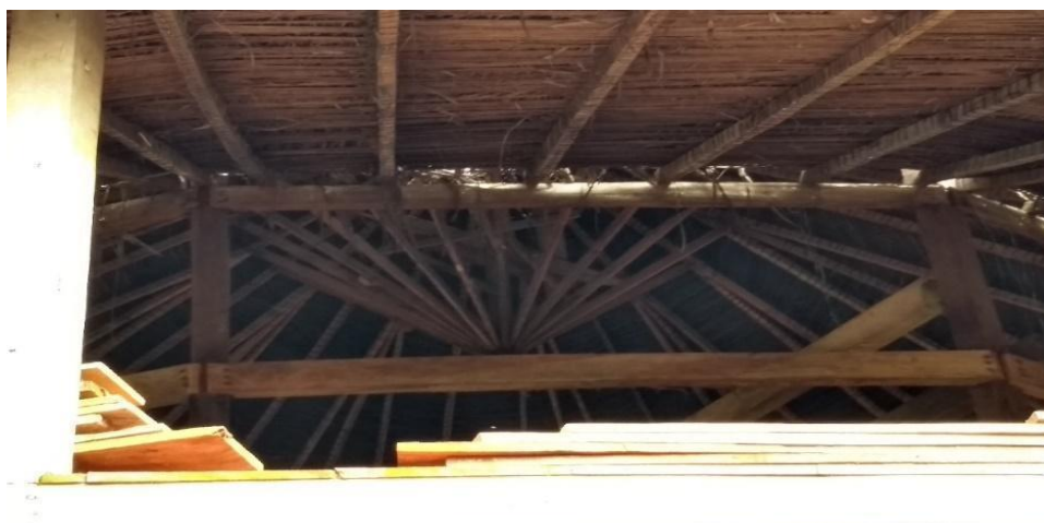
Figura 13 - Detalhe do teto do segundo andar (em construção).
