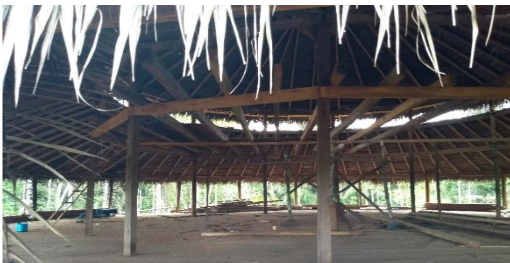
Figura 12 - Parte interna do shuhu (em construção).
