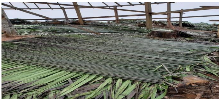
Figura 14 - Detalhe da palha da cobertura
