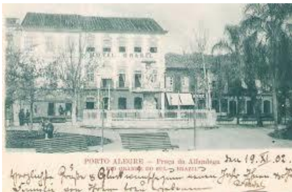
Figura 73: vista de dentro da praça, provavelmente da porta da Alfândega. Ao fundo, o Hotel Brasil (depois Grande Hotel), na Rua da Praia, em 1902.
