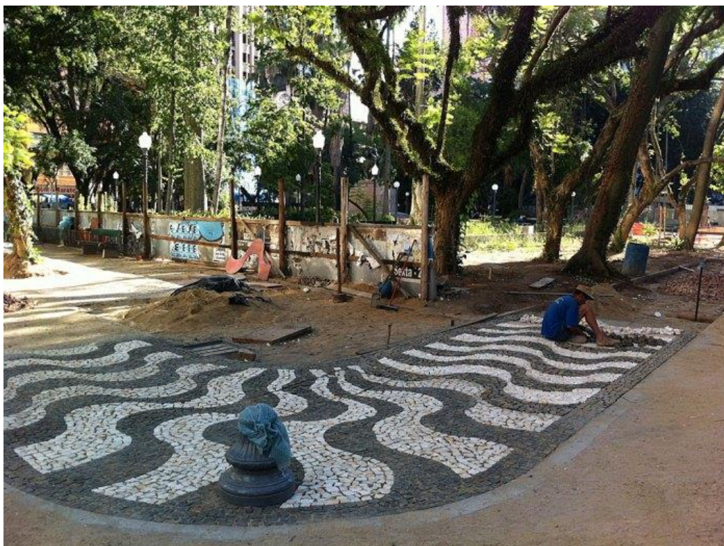
Figura 109: área reservada por tapumes, para obras de calçamento em pedra portuguesa. Vê-se a base do poste antigo, sob proteção - 2011.
