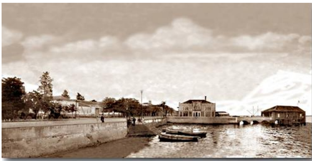
Figura 61: área constituída com a construção do prédio novo da Alfândega, o trapiche e o galpão de carga e descarga de mercadorias. Ao centro da foto, o prédio da Delegacia Fiscal.
