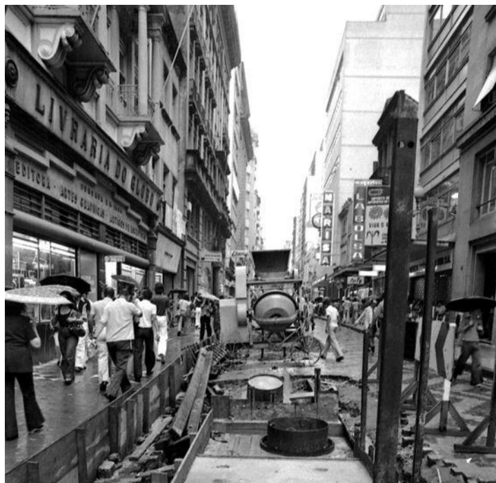
Figura 103: implantação dos calçadões no centro da cidade, exigindo escavação para dutos de gás, luz e telefone na Rua da Praia - década 1970.
