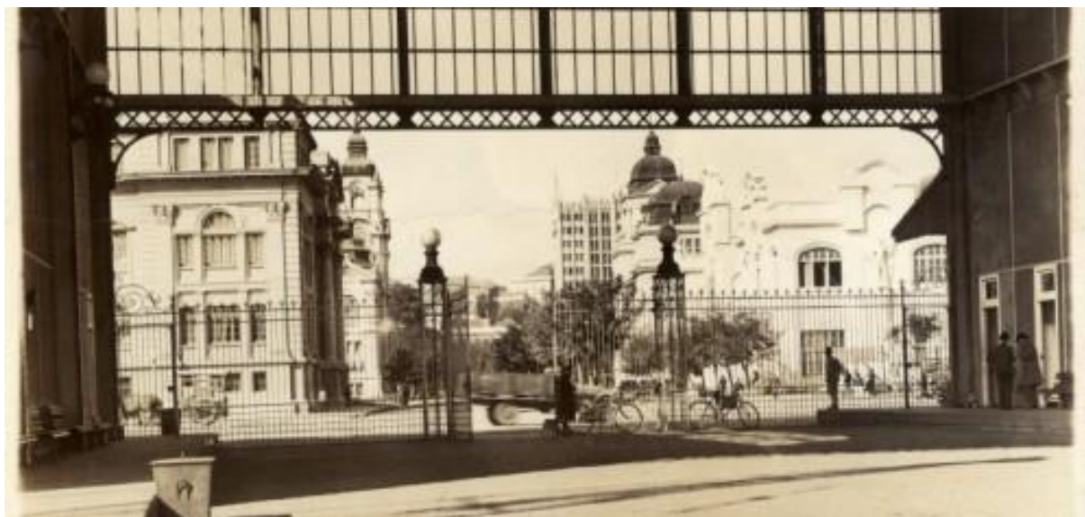
Figura 97: Cais Mauá, interna- década 1930.
