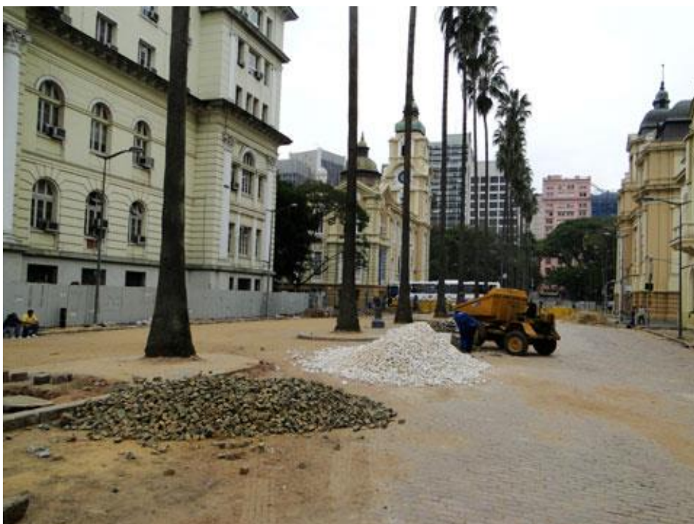
Figura 107: obra de reconstituição do pavimento em pedra portuguesa, nos canteiros da Av. Sepúlveda.
