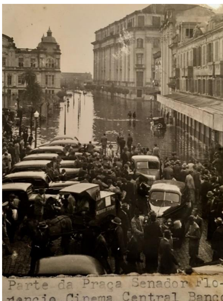
Figura 93: enchente de maio de 1941, na Praça Sen. Florêncio, subida das águas. Ao fundo, Prédios dos Correios (esq.) e Banco do Comercio (dir.). Imagem Acervo AHRS.
