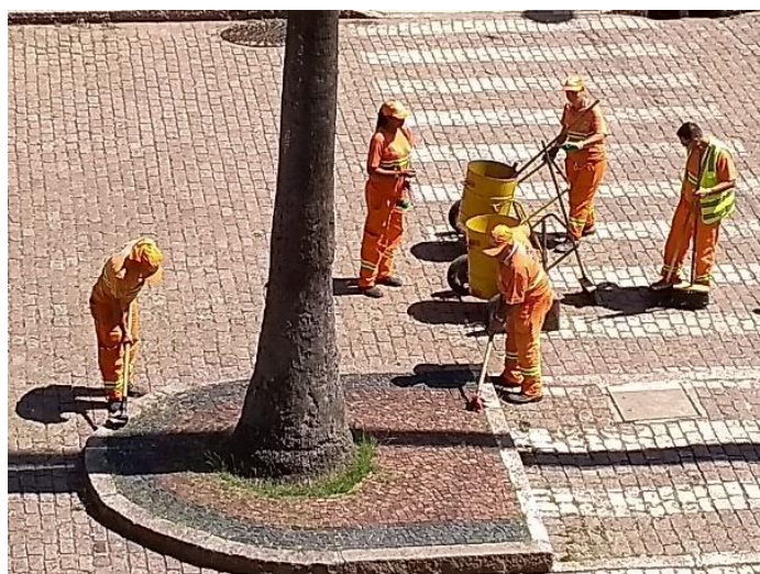
Figura 26: equipe da Prefeitura fazendo a capina dos insos entre as pedras portuguesas nos canteiros. Atividade feita com enxada, gerando um barulho particular da batida do metal na pedra.
