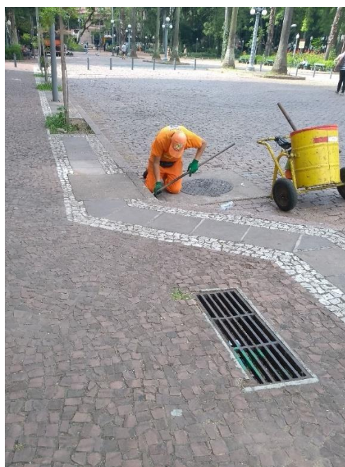
Figura 28: funcionário do DMLU limpando a boca de esgoto - atividade de manutenção.
