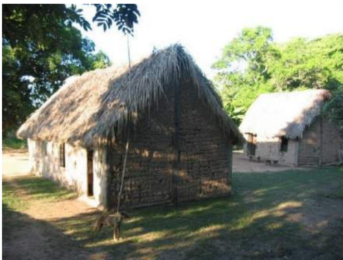
Figura 314 - Casa de pau-a-pique Segundo Lourenço, quartos na frente e cozinha no fundo, a separação era prevenir incêndio Fonte: Galdino, Silva (2009)
