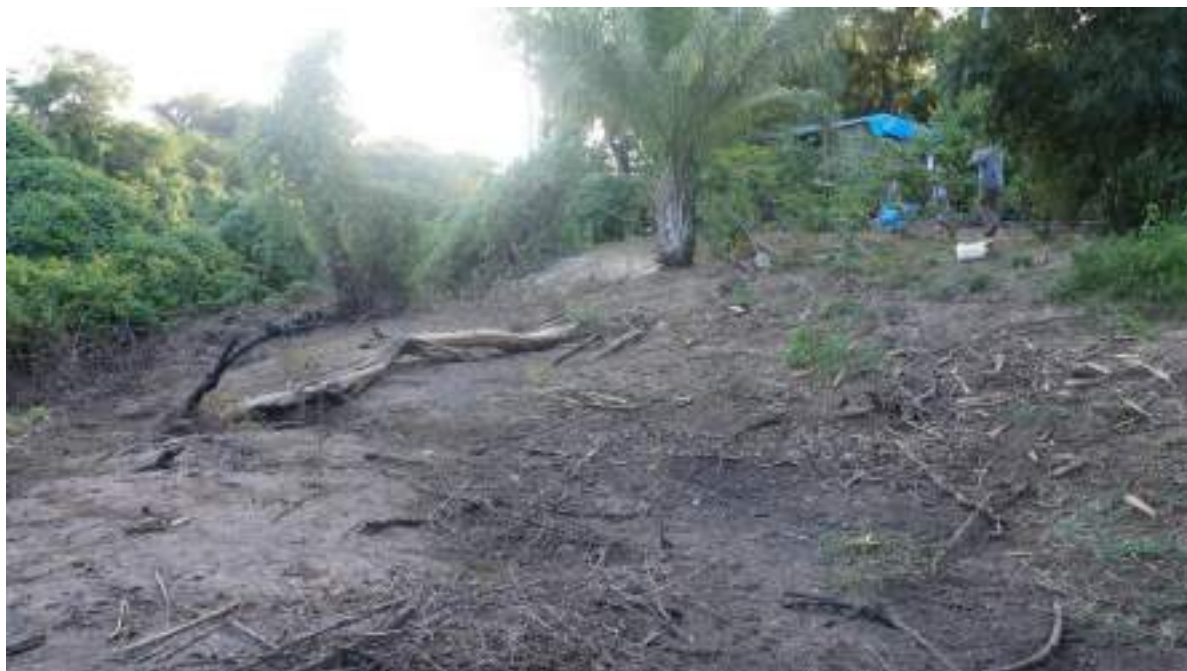
Figura 300 - Caminho do Peixe, margens do Rio Paraguai. Sazonalidade: vazante. Área de empréstimo para formação do aterro.
