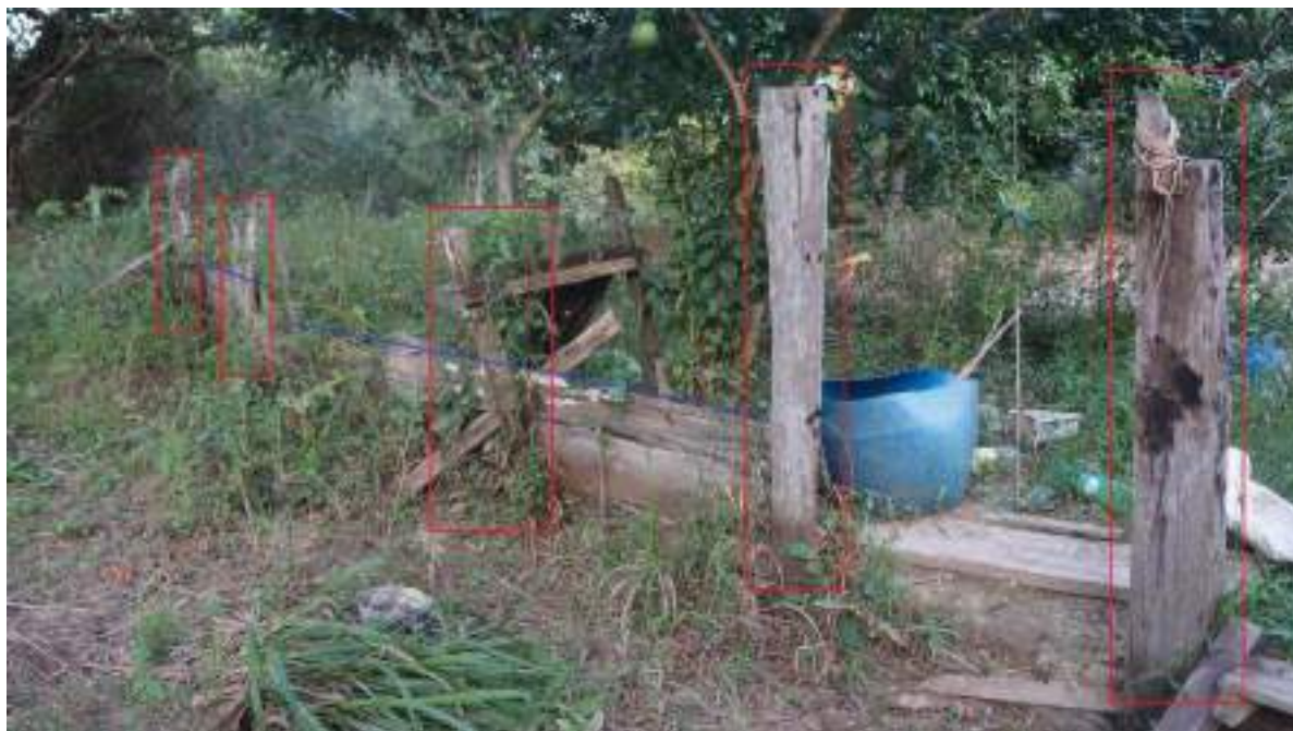
Figura 124 - Aterro do Sr. Zé da Barra: contenção. Margens do Rio Paraguai. Continuidade da contenção do aterro - toco de cerne (vermelho) e linha de pranchão (azul). Parte frontal da casa.
