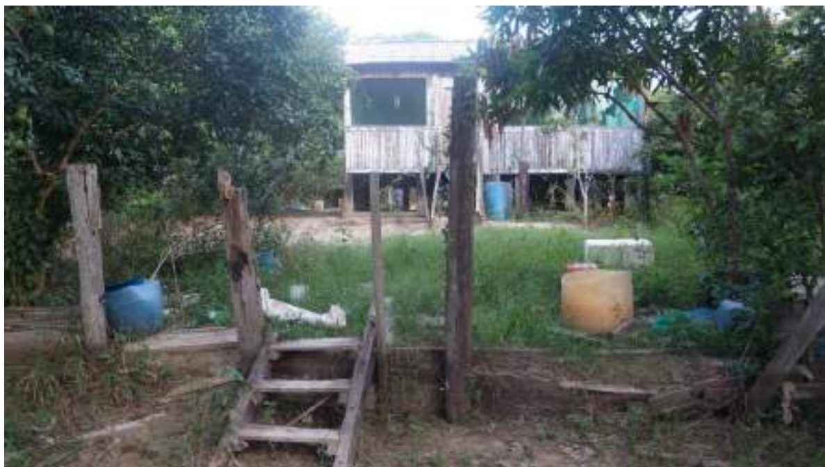
Figura 121 - Aterro do Sr. Zé da Barra, contenção. Margens do Rio Paraguai. Vista da parte frontal da estrutura de habitação em palafita e das contenções do aterro. Fonte: Acervo do autor, 22 abr. 2022
