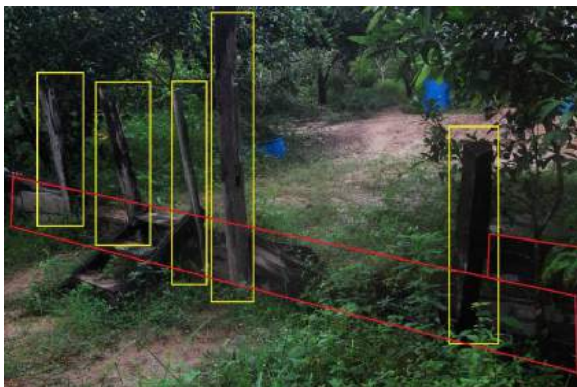
Figura 123 - Aterro do Sr. Zé da Barra: contenções do aterro. Margens do Rio Paraguai. Toco de cerne (amarelo) e pranchão (vermelho). Parte frontal da casa. Fonte: Acervo de Fernando Ozorio, 29 jan. 2022
