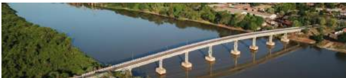
Figura 276 - Ponte Marchal Rondon sobre o rio Paraguai
