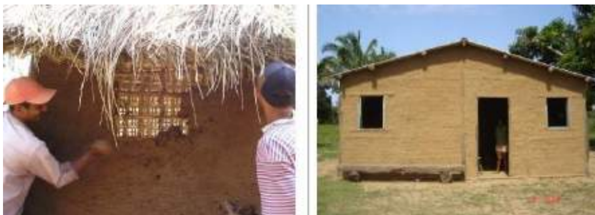
Figura 313 - Casa sendo barreada (esq.). Casa finalizada (dir.) Fonte: Galdino, Silva (2009)
