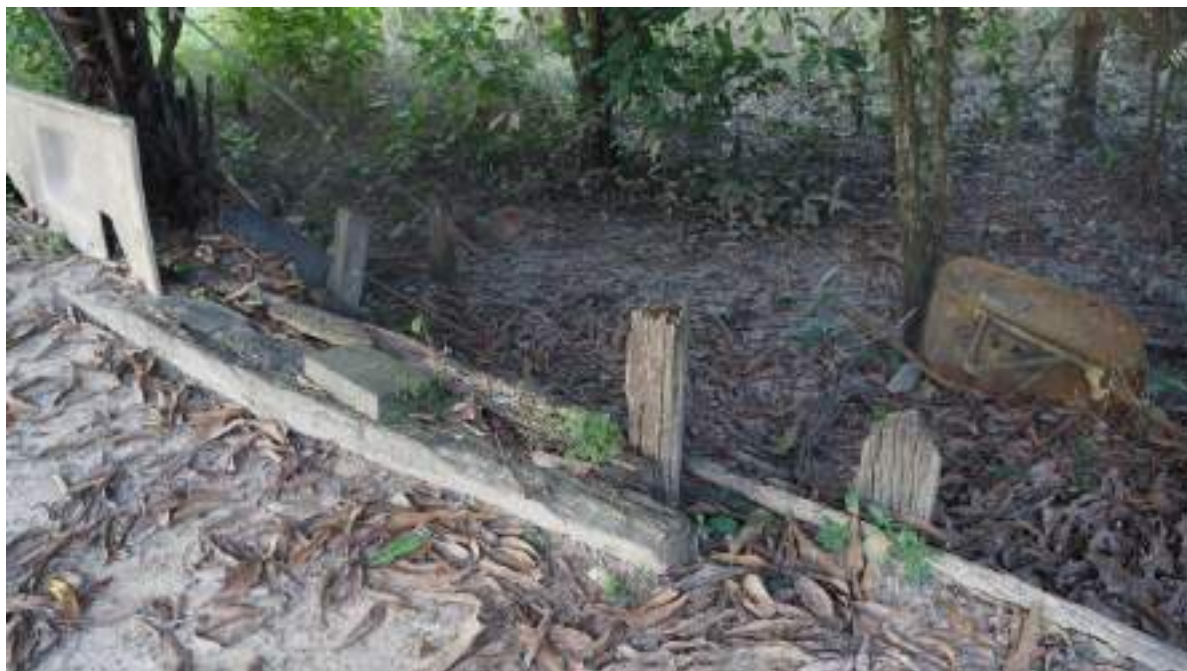
Figura 126 - Aterro do Sr. Zé da Barra. Contenção - toco de cerne. Lateral da casa. Fonte - Acervo do autor, 22 abr. 2022
