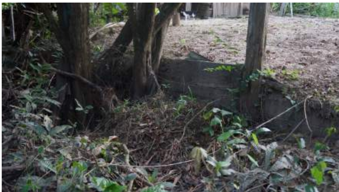
Figura 127 - Aterro do Sr. Zé da Barra. Contenção do aterro - toco de cerne e pranchão. Lateral da casa. Margens do Rio Paraguai. Fonte: Acervo de Fernando Ozorio, 29 jan. 2022
