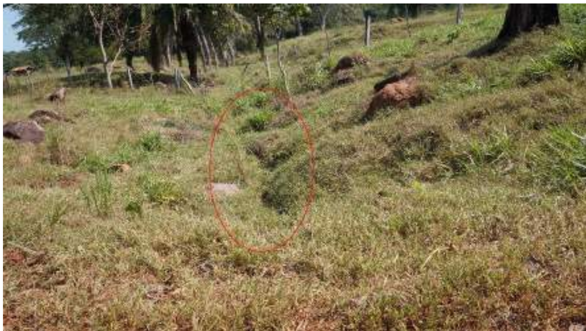
Figura 59 - Rua Pirajá da Silva - Estrada para as Pedras. Calha de drenagem. Fonte: Acervo do autor, 16 jun. 2022
