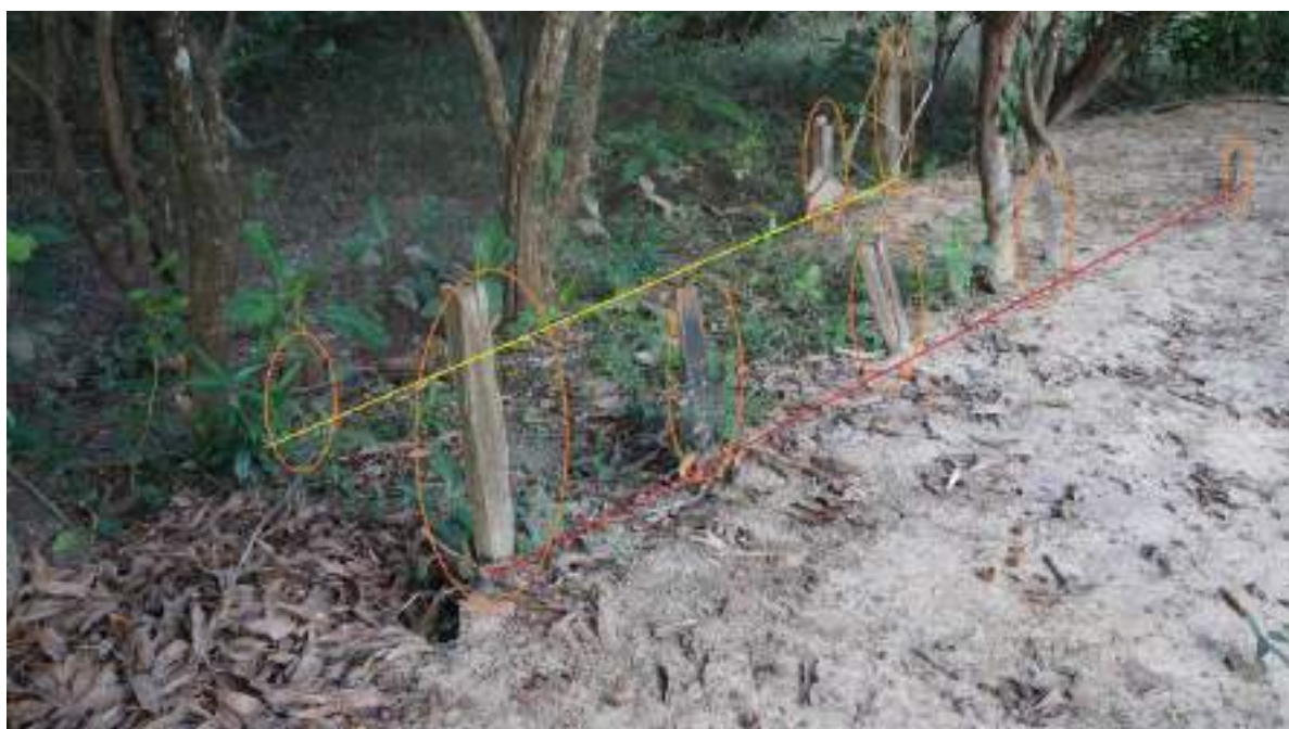
Figura 125 - Aterro do Sr. Zé da Barra: contenções. Margens do Rio Paraguai. Dois alinhamentos de contenção em distintos níveis (linha amarela e vermelha). Toco de cerne (alaranjado). Lateral da casa.
