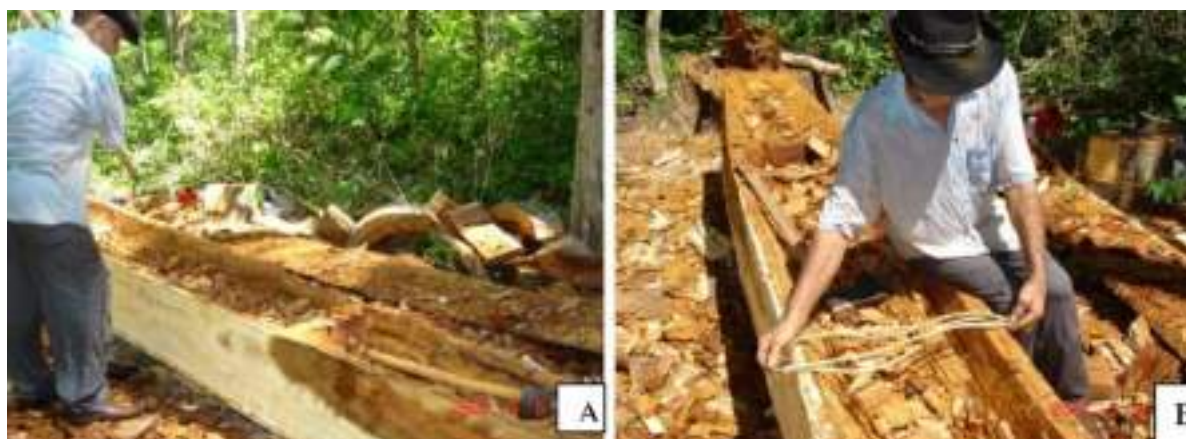
Figura 198 - Finalização da "cavoucação" (esq.), Verificação da medida da boca. Fonte: Victorino (2013 [2006])
