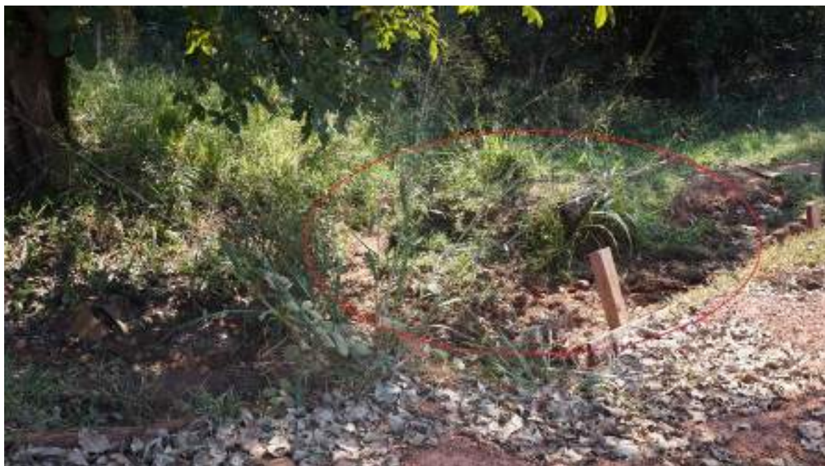
Figura 60 - Rua Pirajá da Silva - Estrada para as Pedras. Calha de drenagem por sob a estrada. Sazonalidade: período de estiagem Fonte: Acervo do autor, 16 jun. 2022
