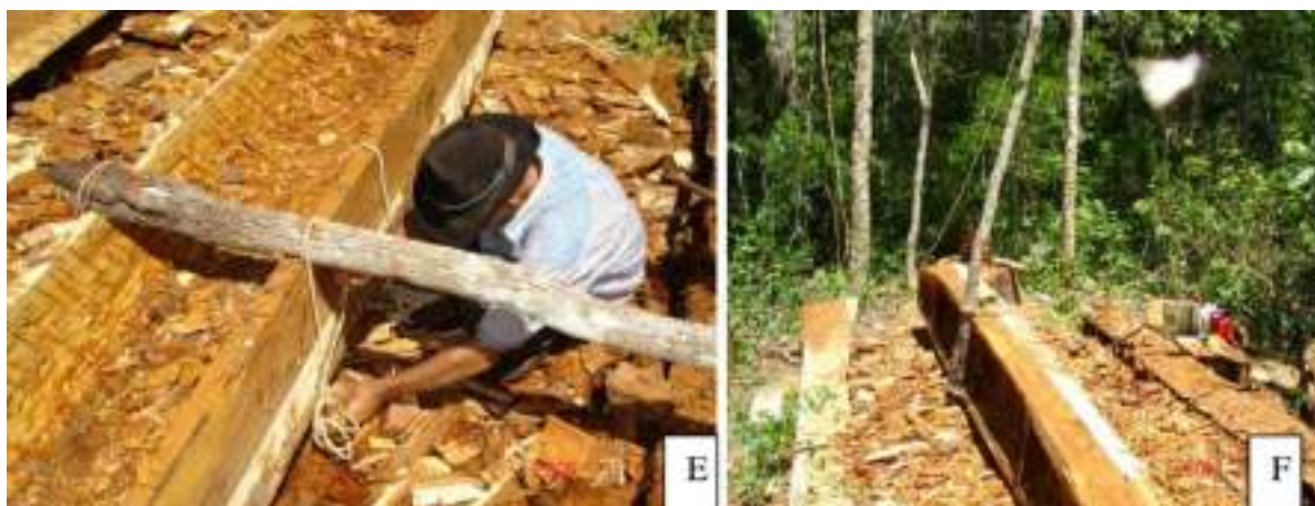
Figura 200 - Uso de alavanca para viração (esq.), Dificuldade na viração. Fonte: Victorino (2013 [2006])
