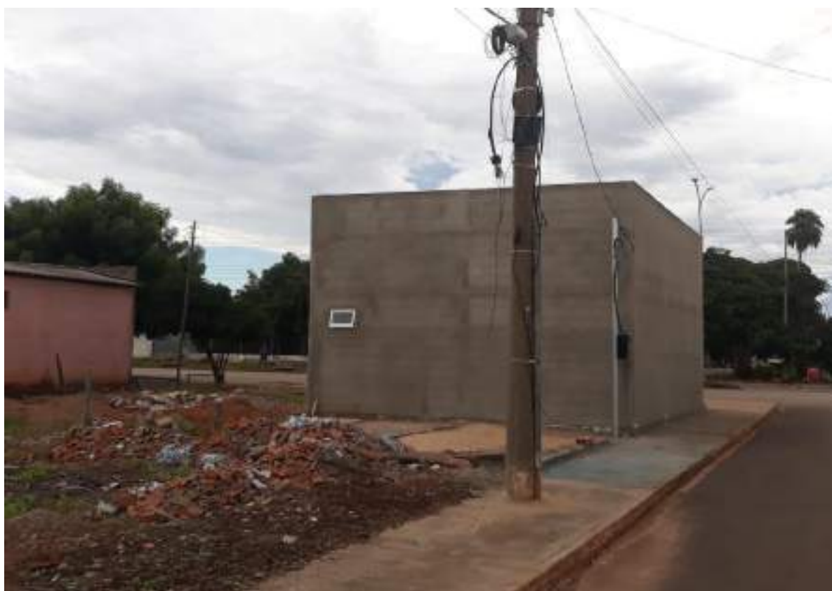
Figura 64 - Desembarque do caminhão de despejo (ver Figura 63). Destaque para construção em andamento. Fotografia em 07/02/2023. Fonte: Acervo do autor, 07 fev. 2023
