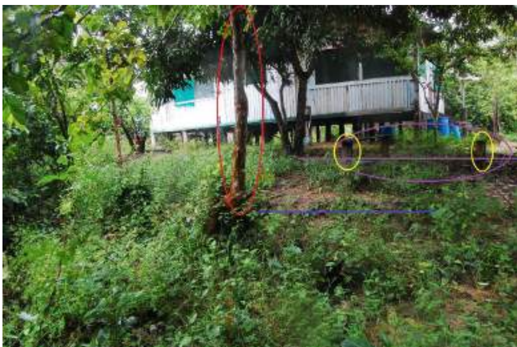
Figura 129 - Aterro do Sr. Zé da Barra: contenção e flora. Toco de cerne (amarelo), dois níveis de elevação (linha azul e violeta). Flora de sustentação do aterro: goiabeira (vermelho). Outras contenções apodreceram. Lateral da casa. Fonte: Acervo de Fernando Ozorio, 29 jan. 2022
