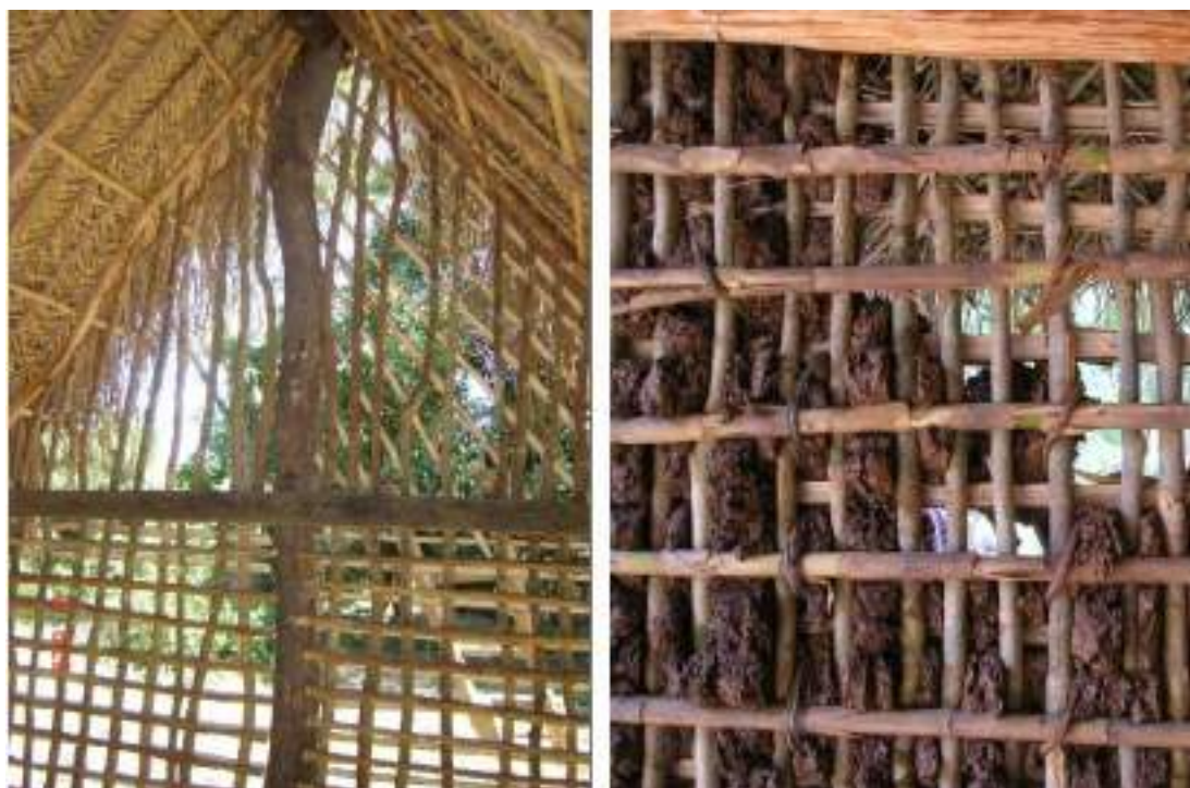
Figura 312 - Casa com madeiras de chão: esteio, barroto e ripa (esq.). Colocação de barro no barroto e ripa (dir.) Fonte: Galdino, Silva (2009)
