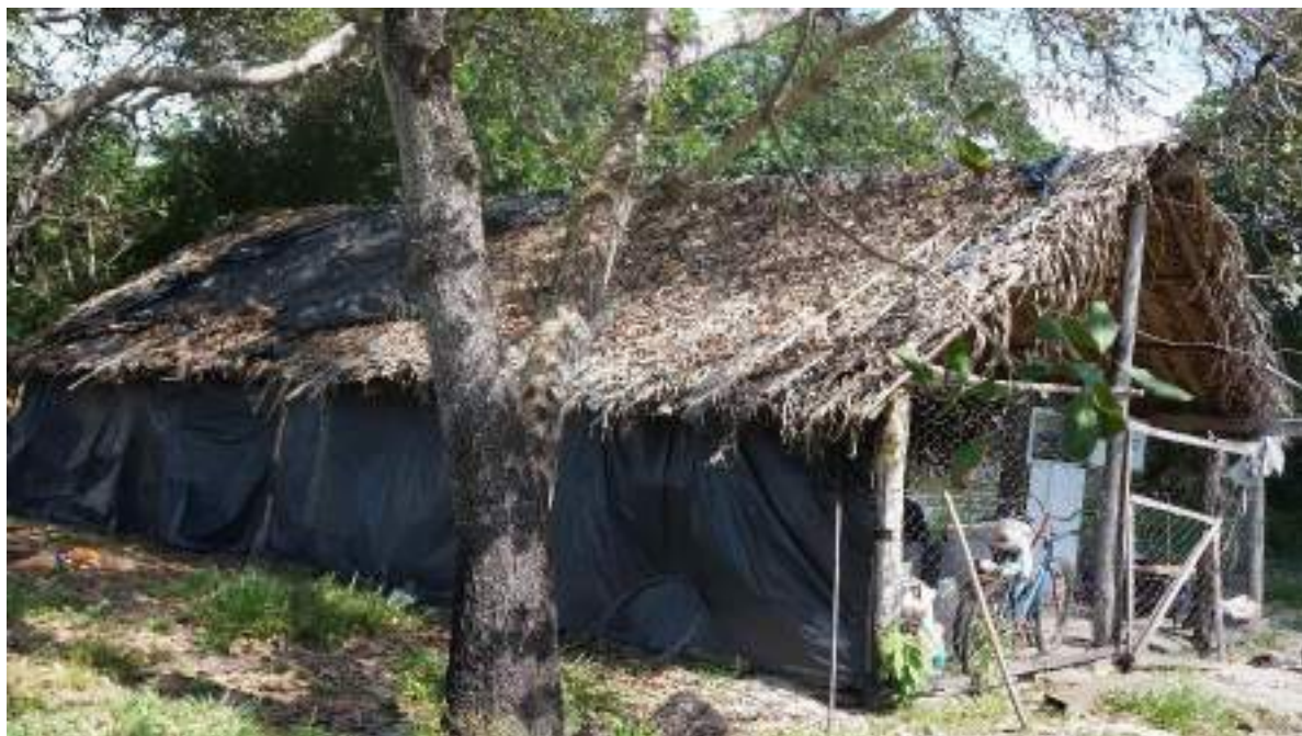
Figura 30 - Estrutura com cobertura de folha de babaçu. Taquaruçu, margens do Rio Sepotuba. Fonte: Acervo do autor, 22 abr. 2022
